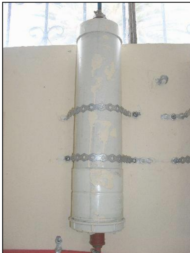
Figura 3.14: Filtro de eliminación de H_2S
