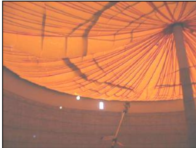
Figura 2.10: Cúpula de un digestor vista desde el interior [12]
