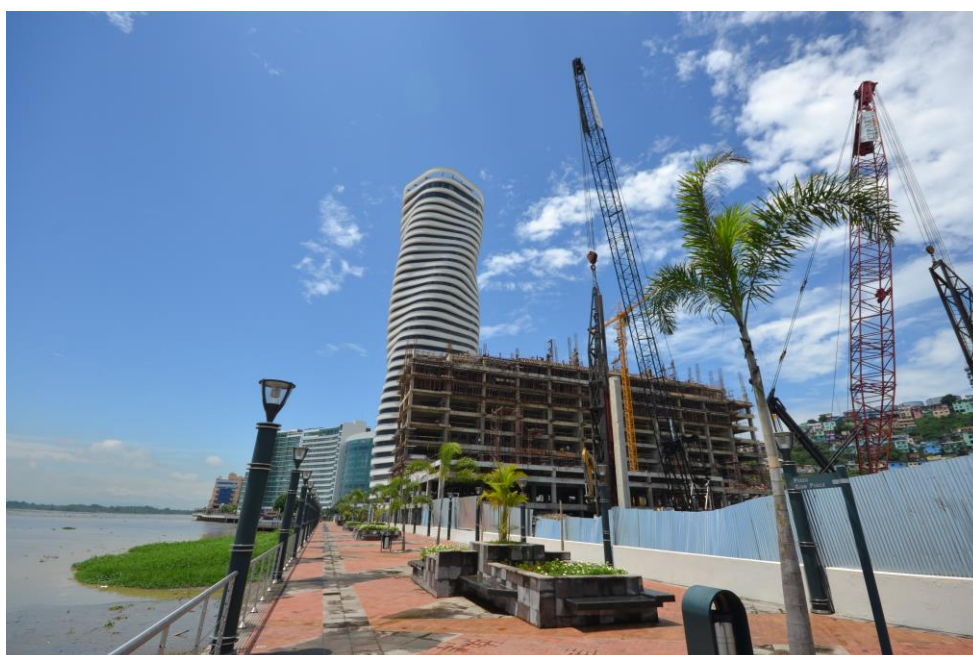
Edificio THE POINT
