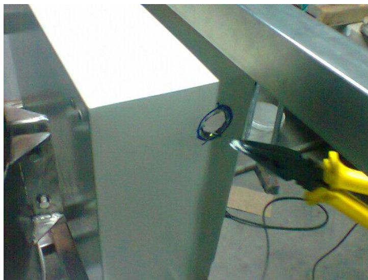
Ilustración 75- Apertura de orificios caja de control
