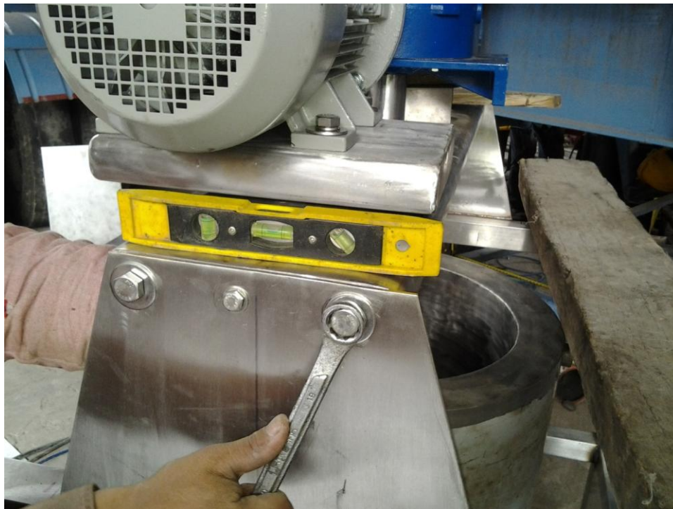
Ilustración 35.- Nivelación Puente de motor
