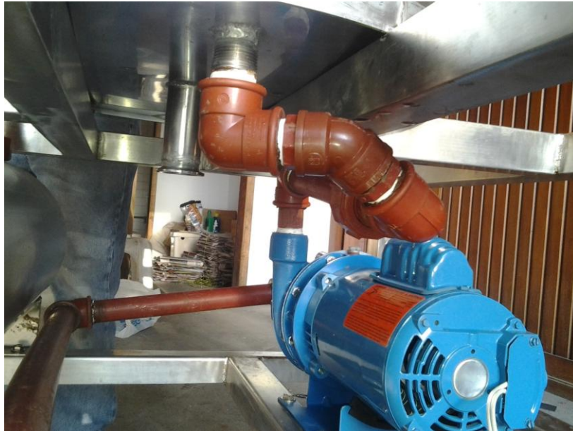
Ilustración 45.- Ensamble tubería salida de la bomba al cilindro
