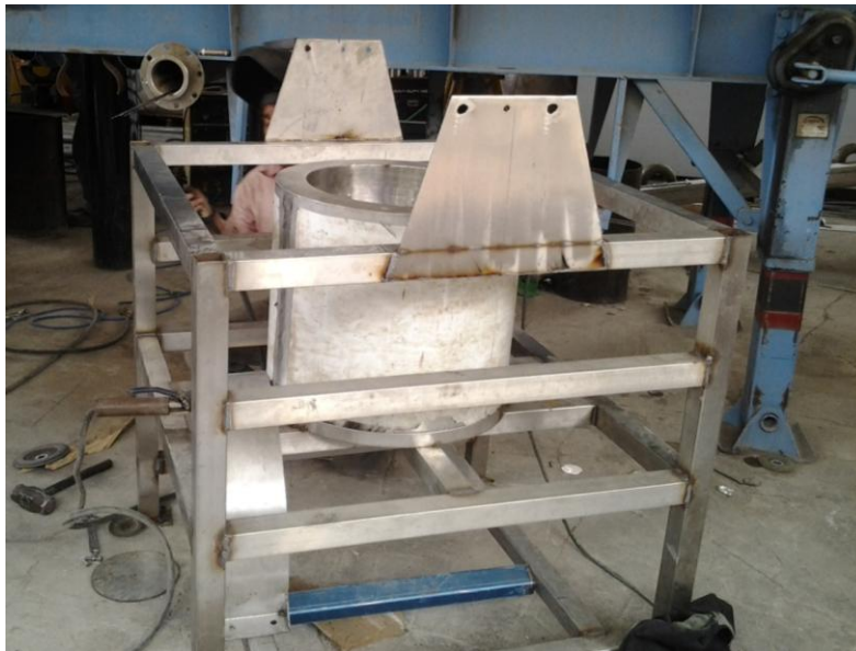
Ilustración 31.- Soldado de soportes para puente
