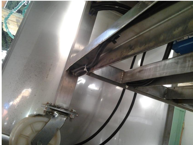
Ilustración 72.- Cableado a través de la estructura
