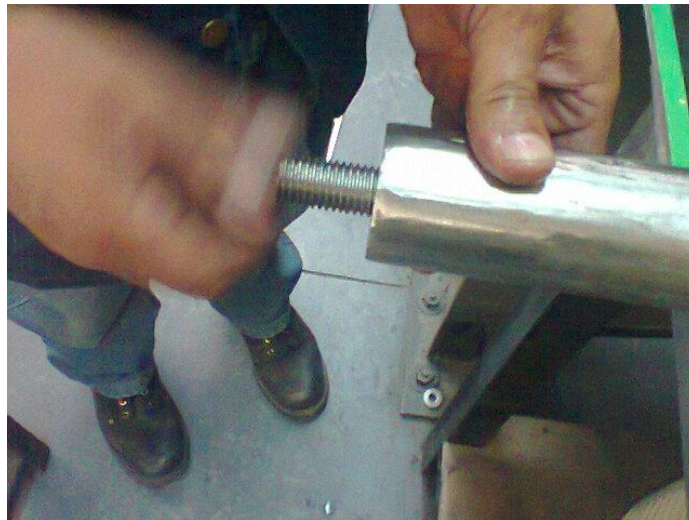
Ilustración 61. -Apertura de hueco para la colocación del perno de 3/4"
