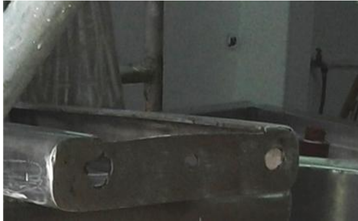
Ilustración 34.- Apertura orificios de sujeción del puente
