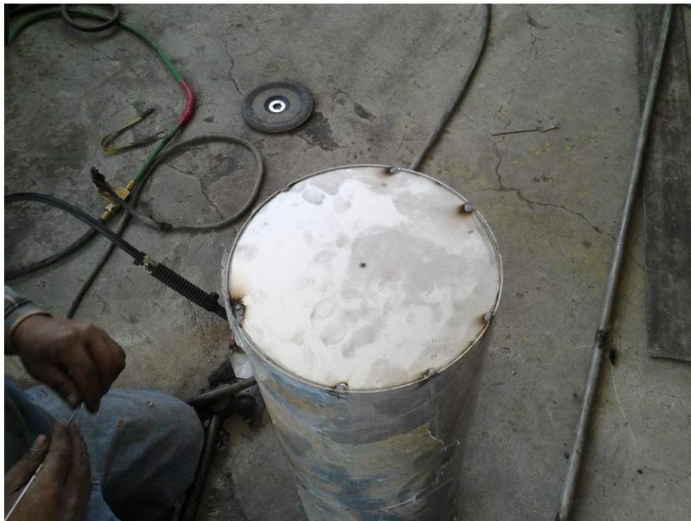
Ilustración 39.- Colocación tapas reservorio de agua
