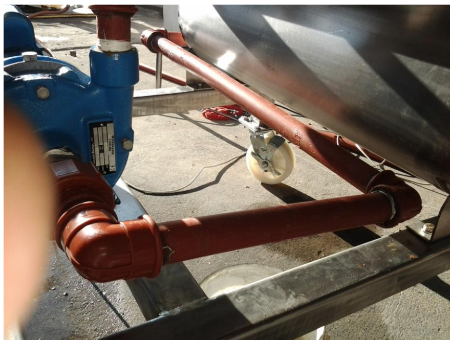
Ilustración 44.- Ensamble tubería salida de agua del reservorio a la bomba
