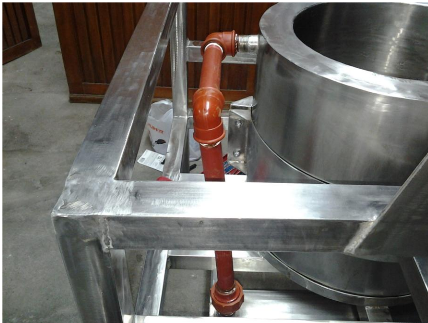
Ilustración 43.- Ensamble tubería salida de agua del cilindro al reservorio
