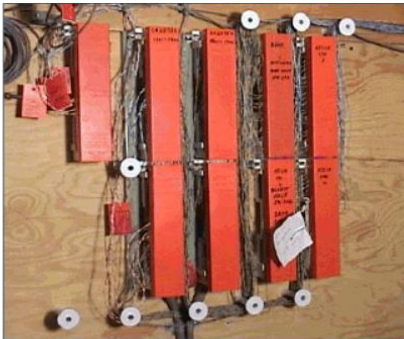
Figura 2.26: Punto de Demarcación
