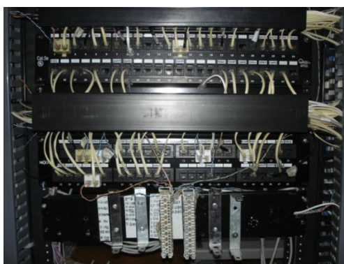
Figura 3.30: Regletas KRONE en reemplazo de Paneles de Interconexión
