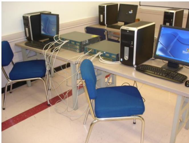
Figura 3.122a: Conmutadores y Emuladores de Terminal (Vista Frontal)
