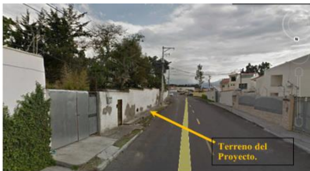
Gráfico 24 Fotografía vista Frente Terreno.
