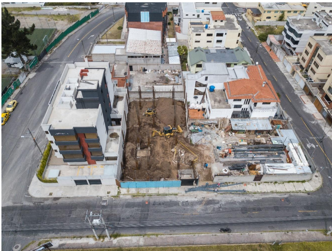
Imagen 30: Terreno Ponceano Park
