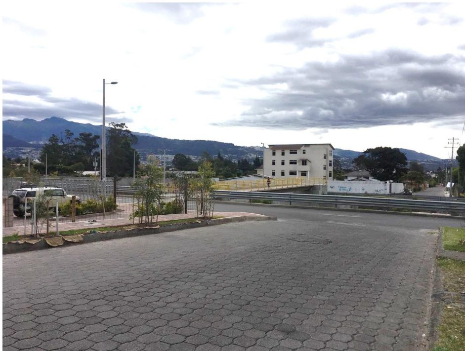
Imagen 3.5: Puente peatonal sobre la Ruta Viva Tomado por: Sebastián Abad
