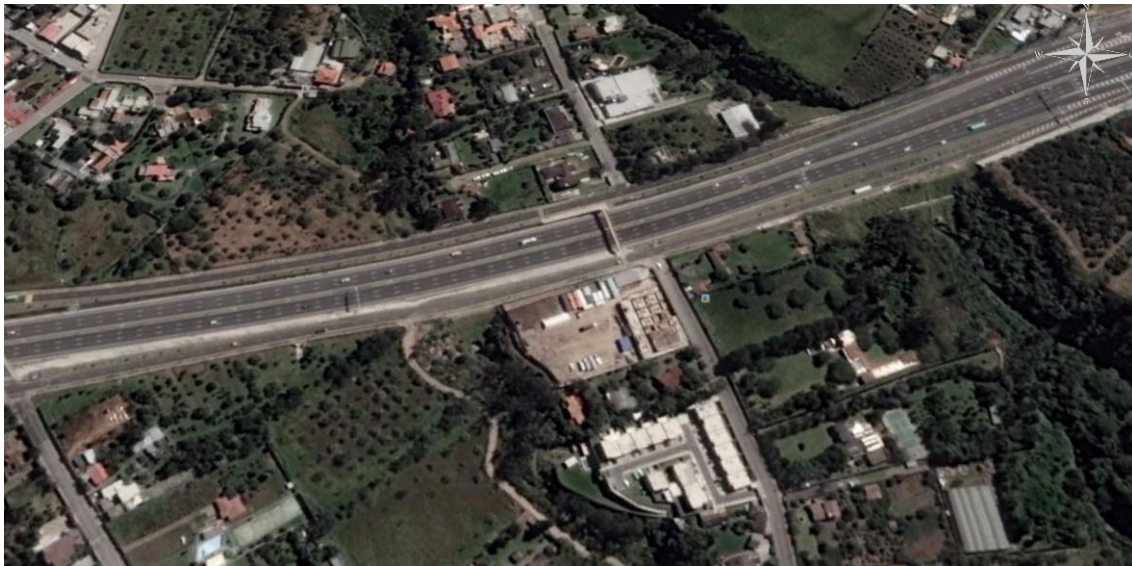
Imagen 5.1: Vista aérea de la zona del proyecto
