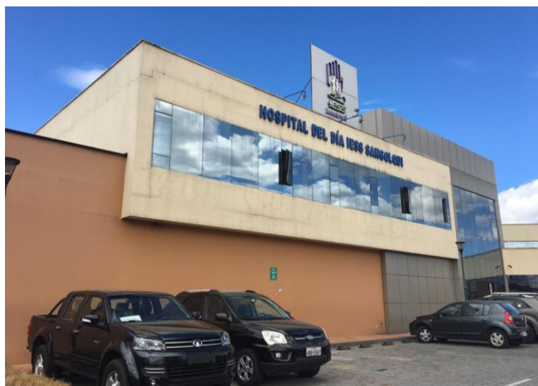
Figura 5. Fachada del Hospital IESS Sangolquí
