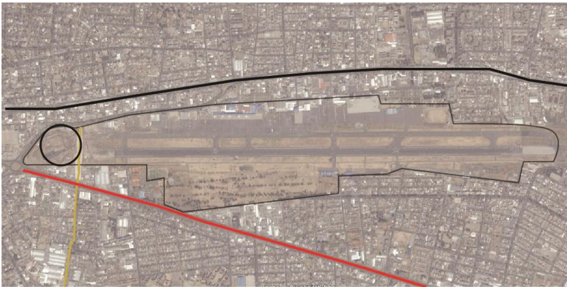
Figura 37. Antiguo Aeropuerto Mariscal Sucre. Año 2014. Fuente: Google Earth.
