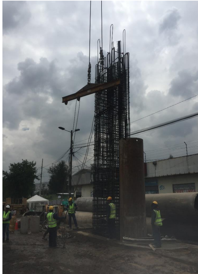
Figura 15. Colocación de pantalla de hormigón armado
