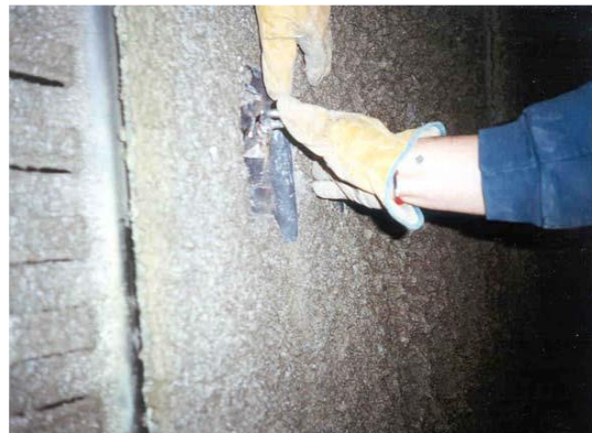
Figura 32. Colocación de perno de convergencia (Consocio Línea 1, 2017)
