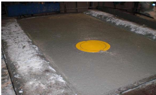
Figura 9. Dovela prefabricada hormigonada (Consortio Línea, 2017)
