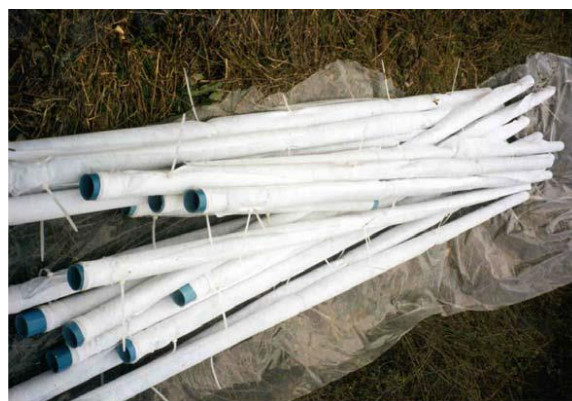
Figura 44. Tubería de PVC para revestimiento de sondeo (Consocio Línea, 2017)
