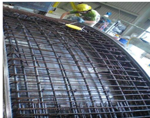
Figura 10. Colocación de celda de presión en armadura del prefabricado (Consortio Línea 1, 2017)
