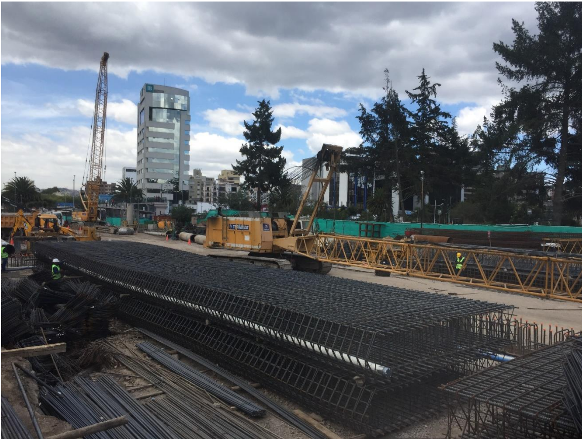
Figura 27. Colocación de inclinómetro en armadura de pantalla
