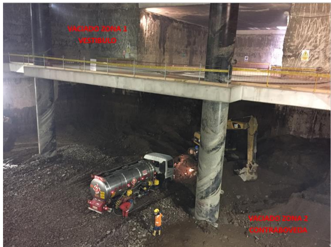
Figura 16. Vaciado de vestíbulo y contra bóveda
