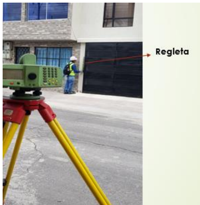
Figura 20. Medición de una regleta de nivelación instalada
