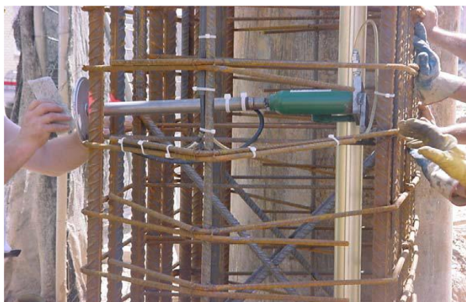
Figura 6. Célula de presión y sistema hidráulico instalado en armadura de pantalla
