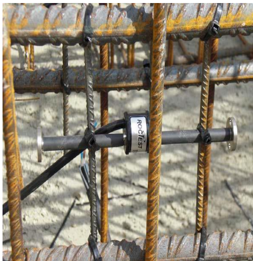
Figura 17. Colocación de extensómetro de cuerda vibrante en acero de dovela (Consortio Línea 1, 2017)
