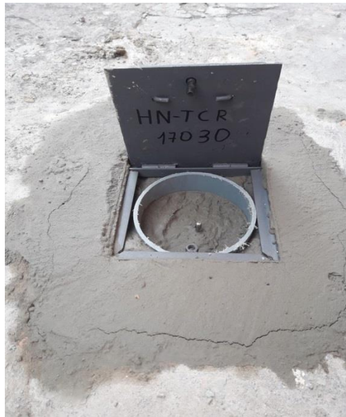
Figura 22. Hito de nivelación instalado en sitio
