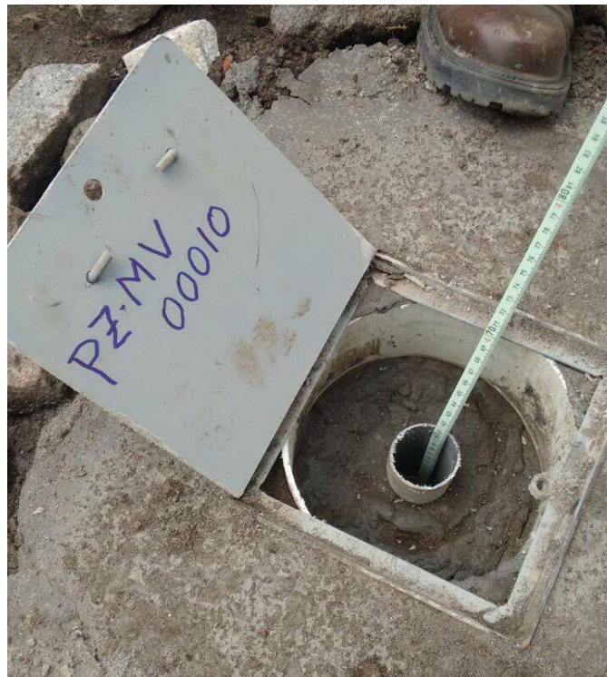
Figura 29. Medición de piezómetro mediante cuerda vibrante
