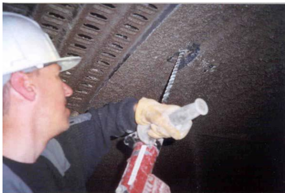
Figura 31. Abertura mediante taladro en sostenimiento metálico (Consocio Línea 1, 2017)
