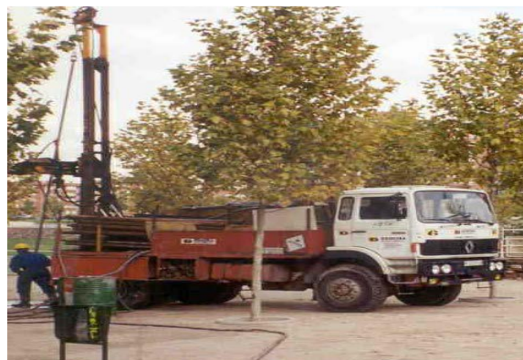
Figura 23. Perforación del sondeo donde se instalará el Inclinómetro vertical (Consocio Línea 1, 2017)
