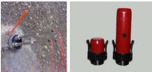
Figura 13. Extensómetro de varilla colocado y protección tipo Consorcio Línea 1, 2017)
