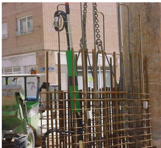
Figura 25. Instalación de Inclinómetro en pantalla (Consocio Línea 1, 2017)
