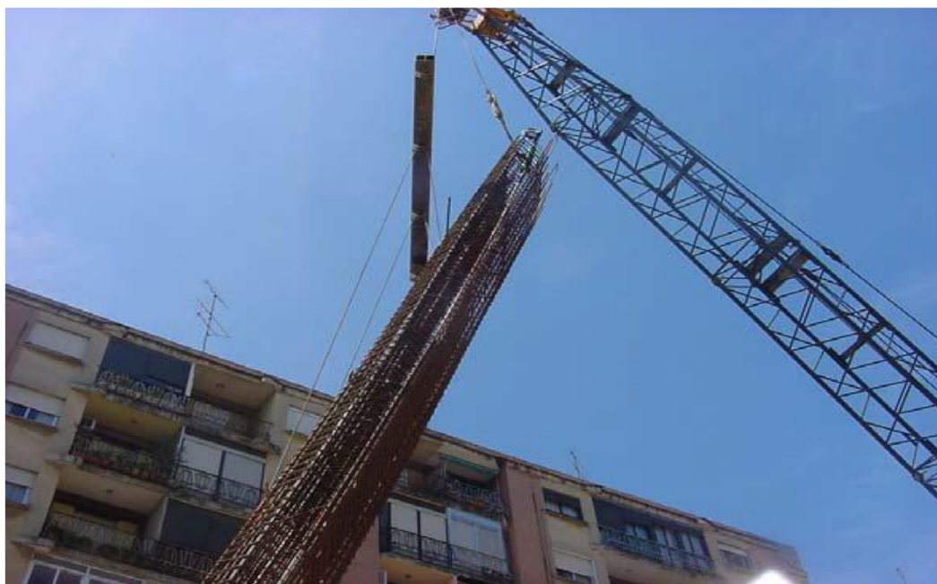
Figura 7. Levantamiento de una armadura de pantalla mediante grúa (Consortio Línea 1, 2017)
