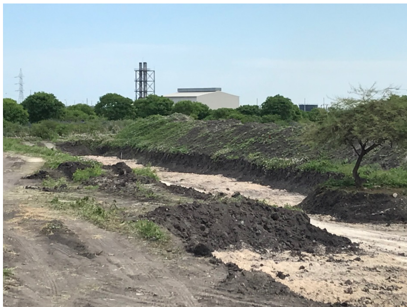
Ilustración 26. Afectación de Ambiental. Ruido: Sub-estación eléctrica Fuente: Visita de Campo Dionicio Gonzabay
