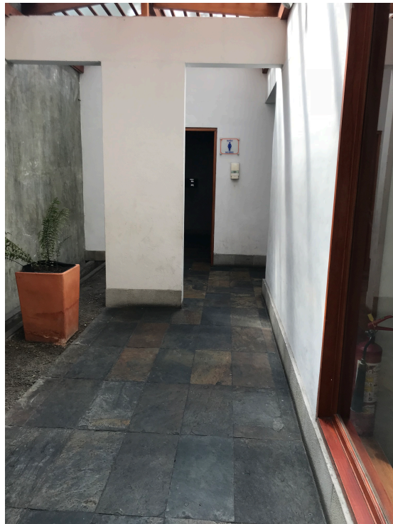
Figura 16. Ingreso a Baños Públicos.
