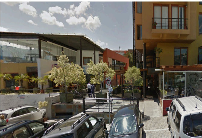
Figura 9. Entrada Peatonal Centro Comercial Centro Plaza.
