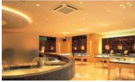
Figura 19. Vista de un espacio con equipos tipo Cassette. Mitsubishi. City Multy.
