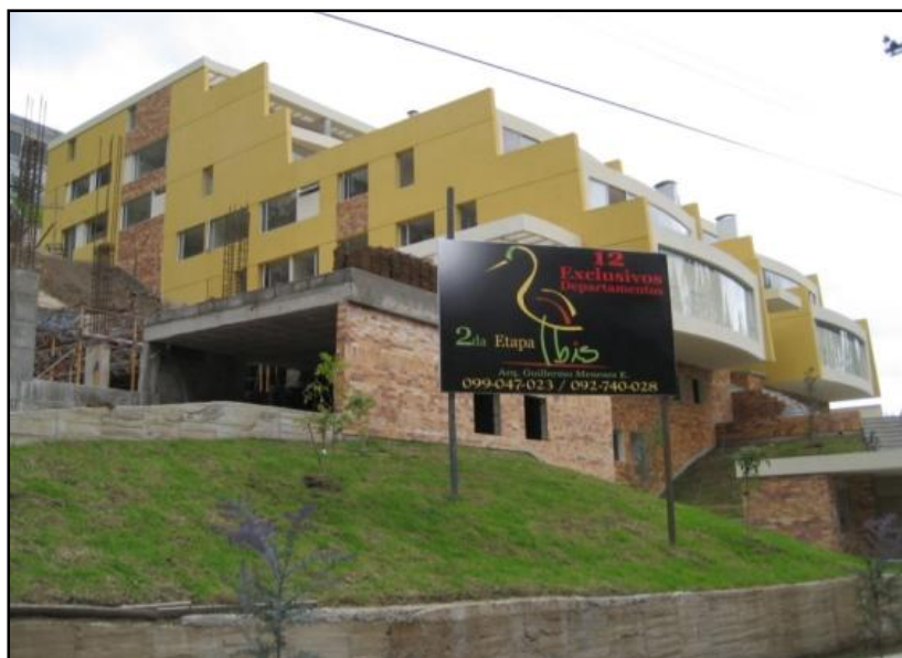
Figura 4-3 Valla frente al edificio
