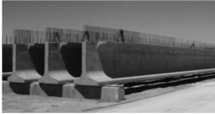
Ilustración 19. Viga Prefabricada Tipo "I" (Chen & Duan, 2014).
