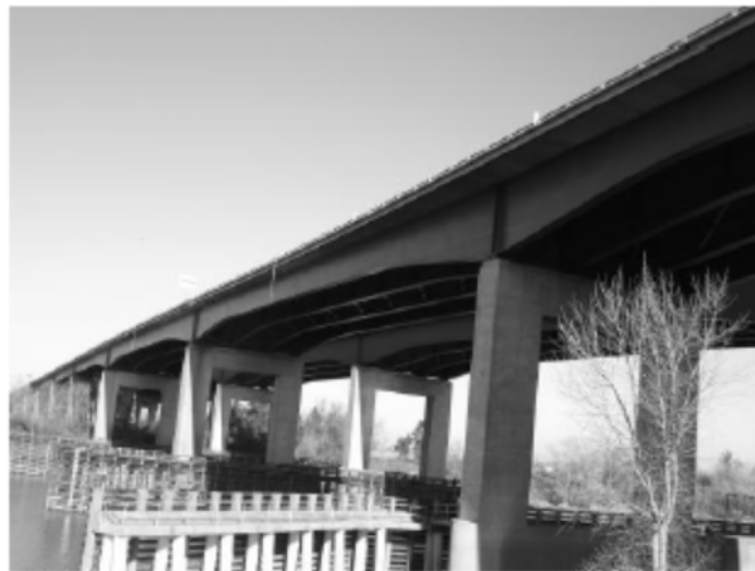
Ilustración 10. Marcos de hormigón armado típicos (Chen & Duan, 2014).
