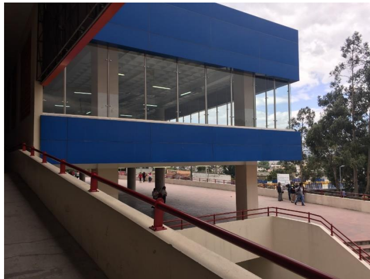
Figura 12 Vista fachada frontal del mercado, observar vidrio, barandales y piso de bloque.
