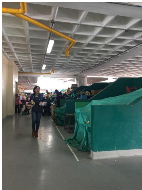
Figura 9 Vista interior, observar estructura de techo. Fuente: Original
