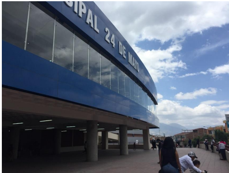
Figura 11 Vista fachada frontal del mercado, observar paneles de alucobond. Fuente: Original
