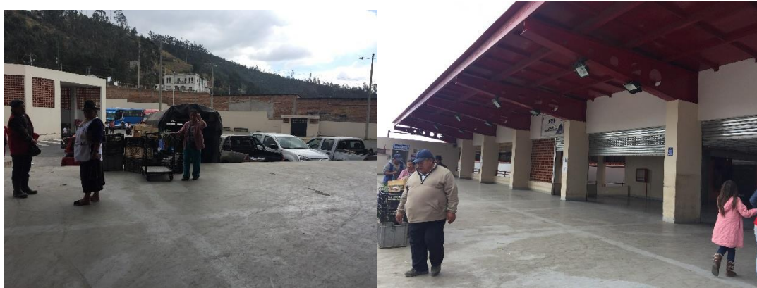
Figura 25 Vista desde el parqueadero del área de carga y descarga. Fuente: Original.
