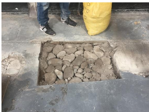
Fotografía 30: Zona derrocada de 60x90x10 [cm] con material de mejoramiento listo para recibir fundición de hormigón
