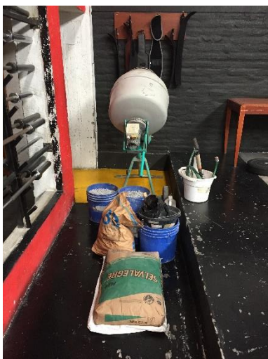
Fotografía 31: Materiales usados para la fundición InSitu
