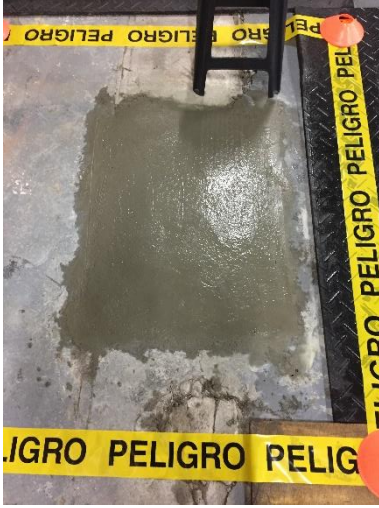
Fotografía 33: Hormigón con acabado realizado
