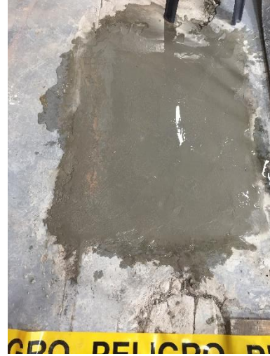
Fotografía 34: Proceso de curado mediante el riego de agua
