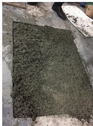
Fotografía 32: Hormigón fundido InSitu
