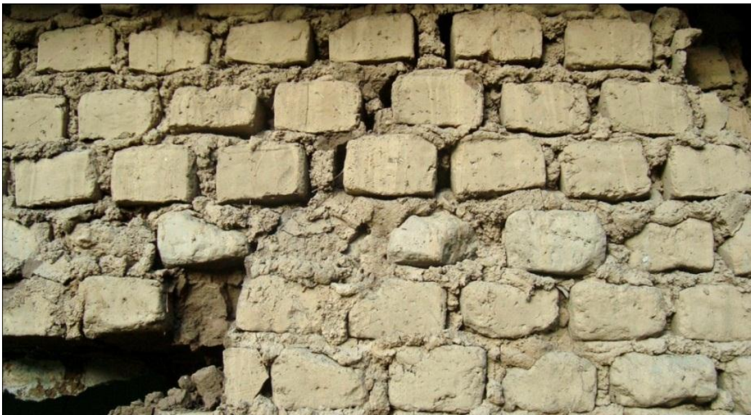
Fig 11. Muro de Adobe (Comunidad de Camuendo, Imbabura)
