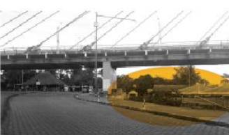
Figura 31. Plaza bajo puente
