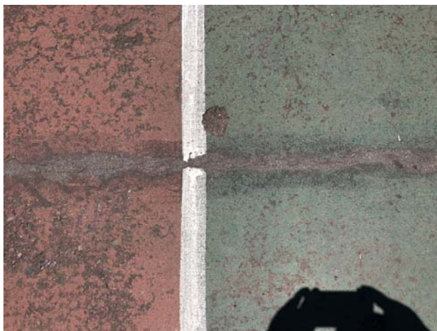
Figura 2. Situación de la cancha de tenis.
