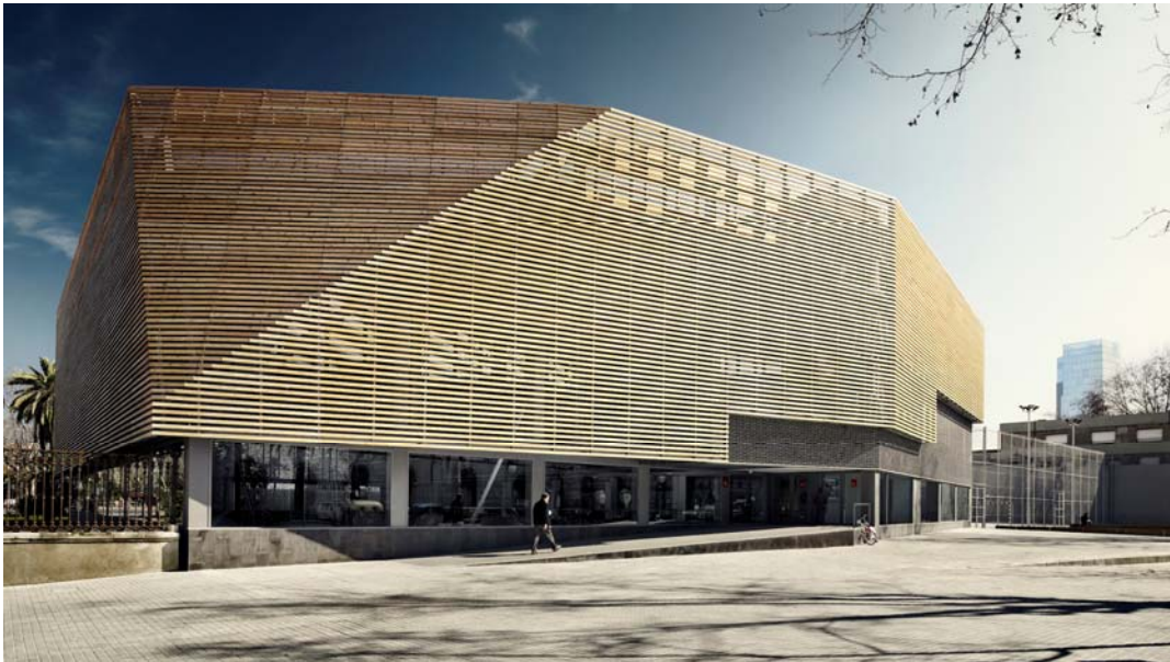
Figura 10. Imagen del proyecto construido.
