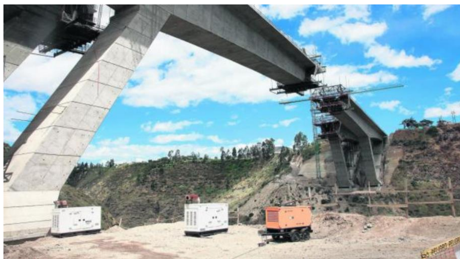
Figura No. 59: Lanzamiento de los segmentos de hormigón
