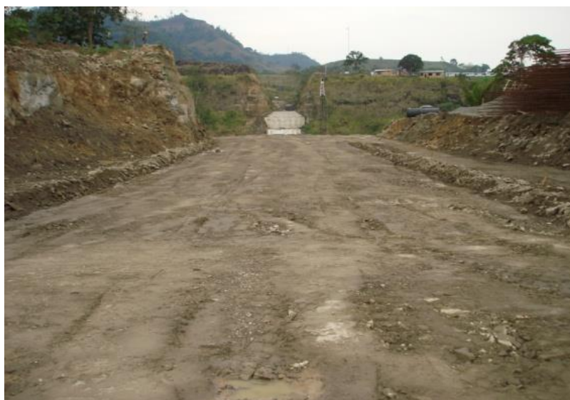
Figura No. 35: Plataforma de lanzamiento perfectamente nivelada
