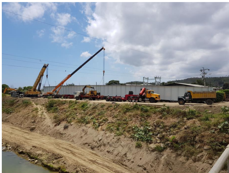
Figura No. 62: Movimiento mediante dollies de las vigas metálicas paralelas al Río Jama
