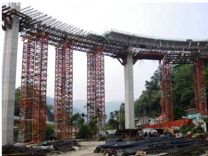
Figura No. 8: Pilas auxiliares construidas entre pilas
