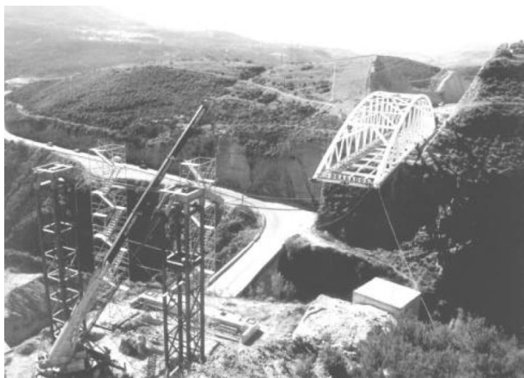
Figura No. 21: Esquema general de lanzamiento con estructura H
