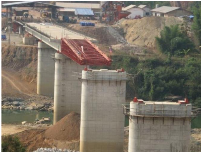
Figura No. 1: Esquema general del lanzamiento por segmentos
