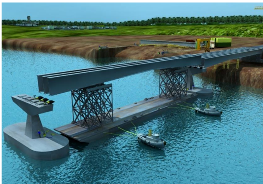
Figura No. 51: Lanzamiento de las vigas metálicas sobre el Río Esmeraldas
