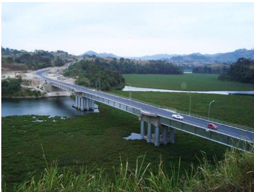
Figura No. 33: Puente Carrizal - Manabí ubicado en la Presa La Esperanza en la vía Quiroga – Pichincha
