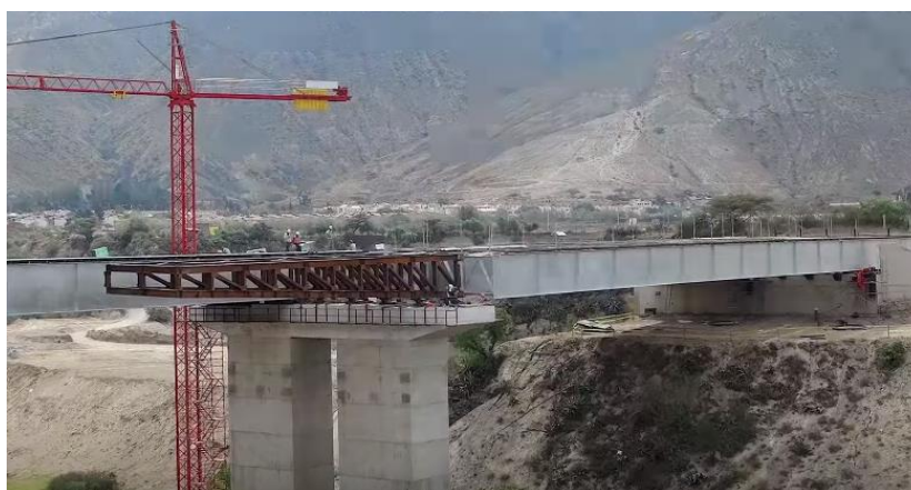
Figura No. 64: Lanzamiento de las vigas metálicas del puente Los Pájaros
