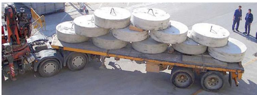
Figura No. 24: Muertos de hormigón que van dentro del suelo para anclar la estructura
