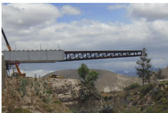
Figura No. 4: Pico de lanzamiento
