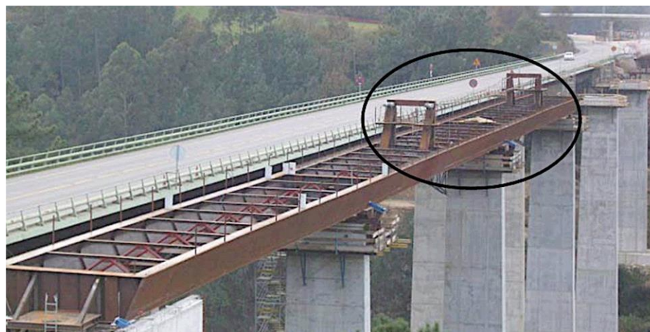
Figura No. 31: Viaducto de San Roque, Asturias, España
