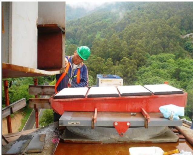
Figura No. 5: Apoyo de neopreno-teflón
