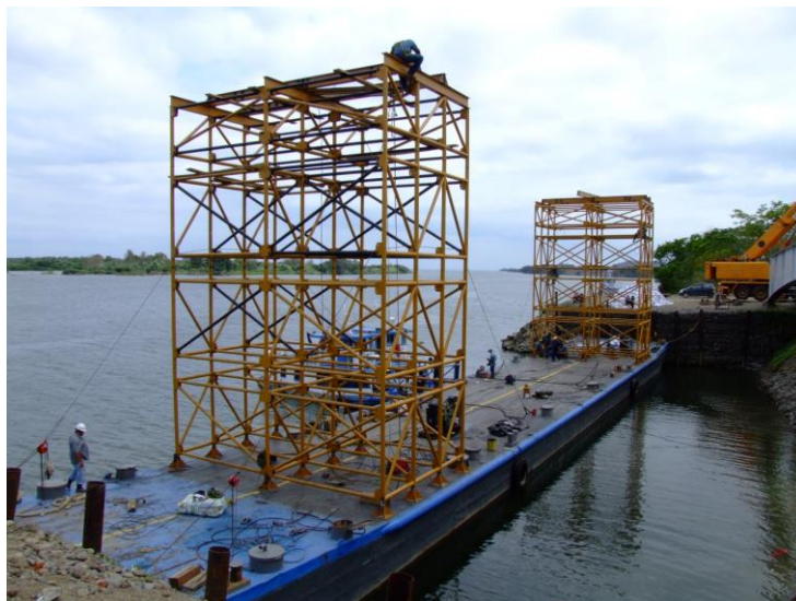
Figura No. 55: Barcaza y pórticos autoportantes para transporte de vigas metálicas
