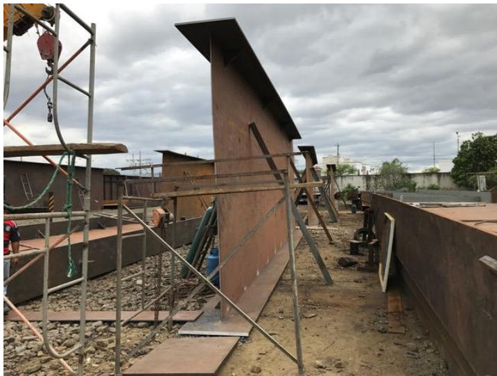
Figura No. 52: Pre-montaje de las vigas de lanzamiento en tierra
