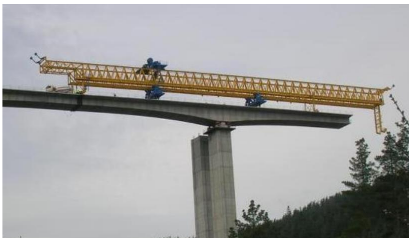
Figura No. 13: Esquema general del lanzamiento con viga lanzadora
