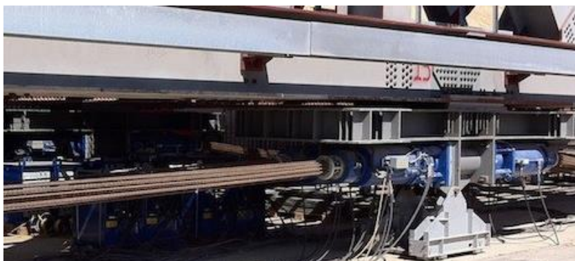
Figura No. 67: Gatos Strand utilizados para el lanzamiento incremental
