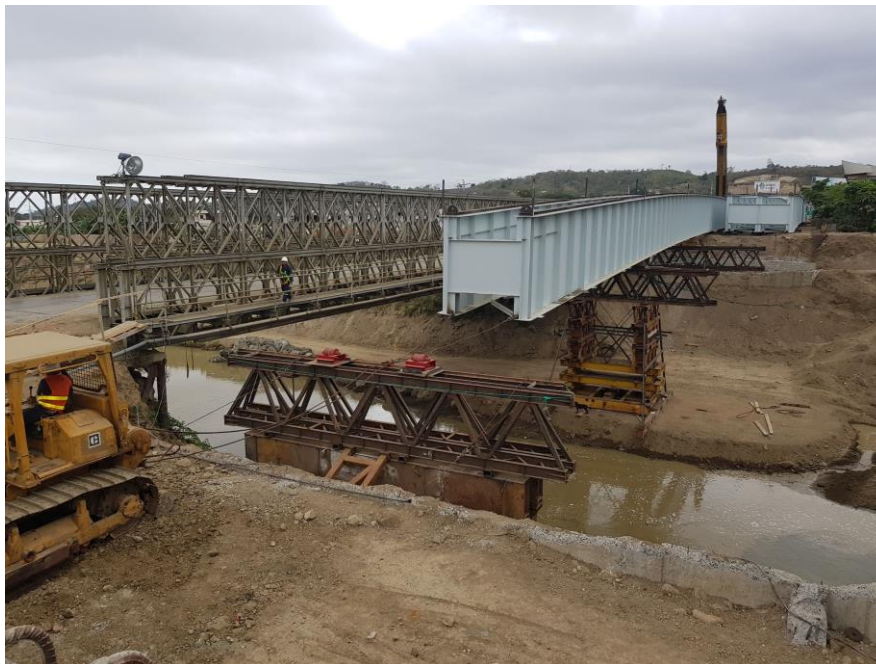
Figura No. 63: Lanzamiento de las vigas donde se observa las pilas auxiliares, rodillos, grúa y el tractor para tirar las vigas
