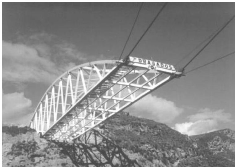
Figura No. 22: Cables tensionados diagonalmente al eje de lanzamiento
