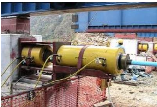
Figura No. 6: Cilindros hidráulicos de doble acción
