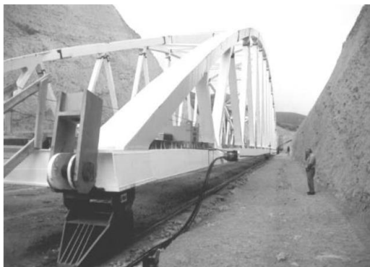
Figura No. 23: Rieles longitudinales donde se desplazará la estructura
