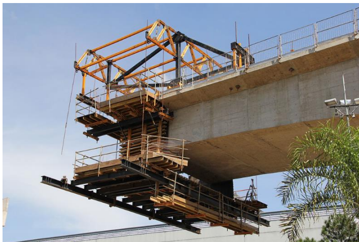
Figura No. 20: Carro de avance para el lanzamiento sucesivo
