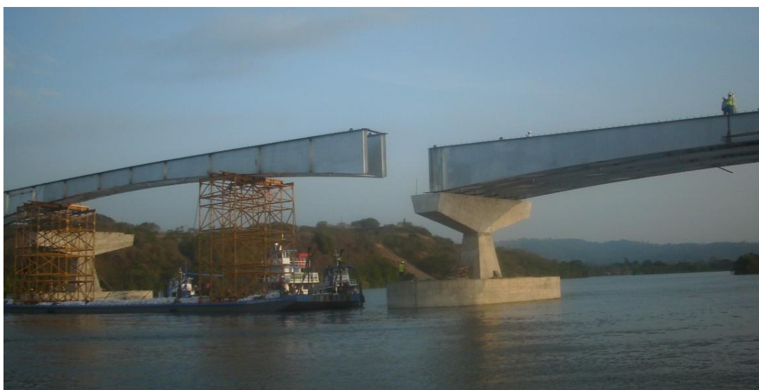
Figura No. 57: Descenso a la posición final de las vigas metálicas
