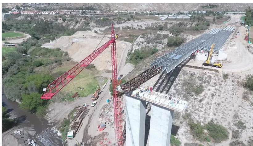
Figura No. 66: Lanzamiento de las 4 vigas utilizando el método incremental
