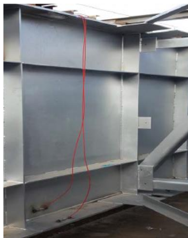
Figura No. 69: Cables vibrantes TFR, WH, BFR instalados en la sección S1
