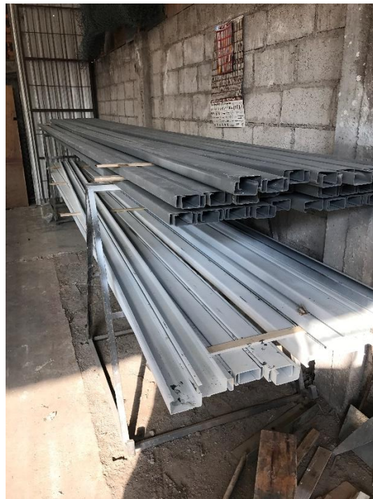
Fotografía 3. Preparación de estructura metálica.
