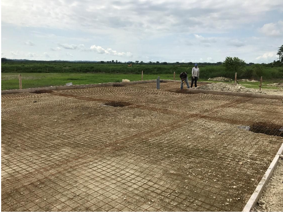
Fotografía 4. Fundido de losas.
