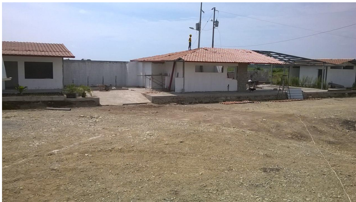
Fotografía 12. Trabajos de pintura.
