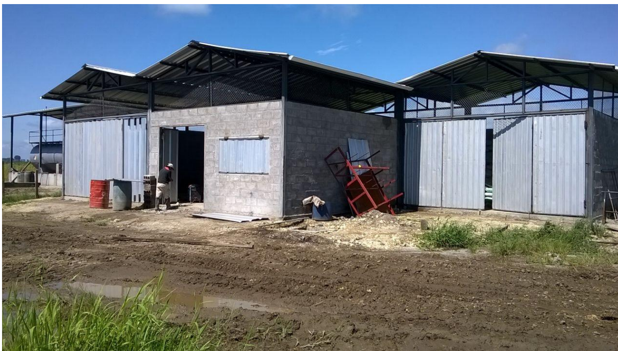
Fotografía 9. Trabajos de albañilería.
