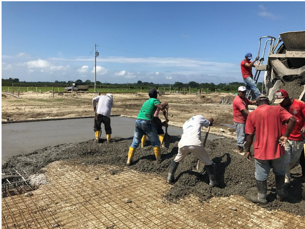
Fotografía 5. Fundido de losas.
