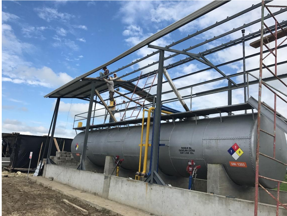
Fotografía 6. Armado de estructura metálica.
