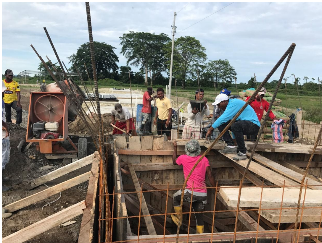
Fotografía 8. Construcción de la cisterna.
