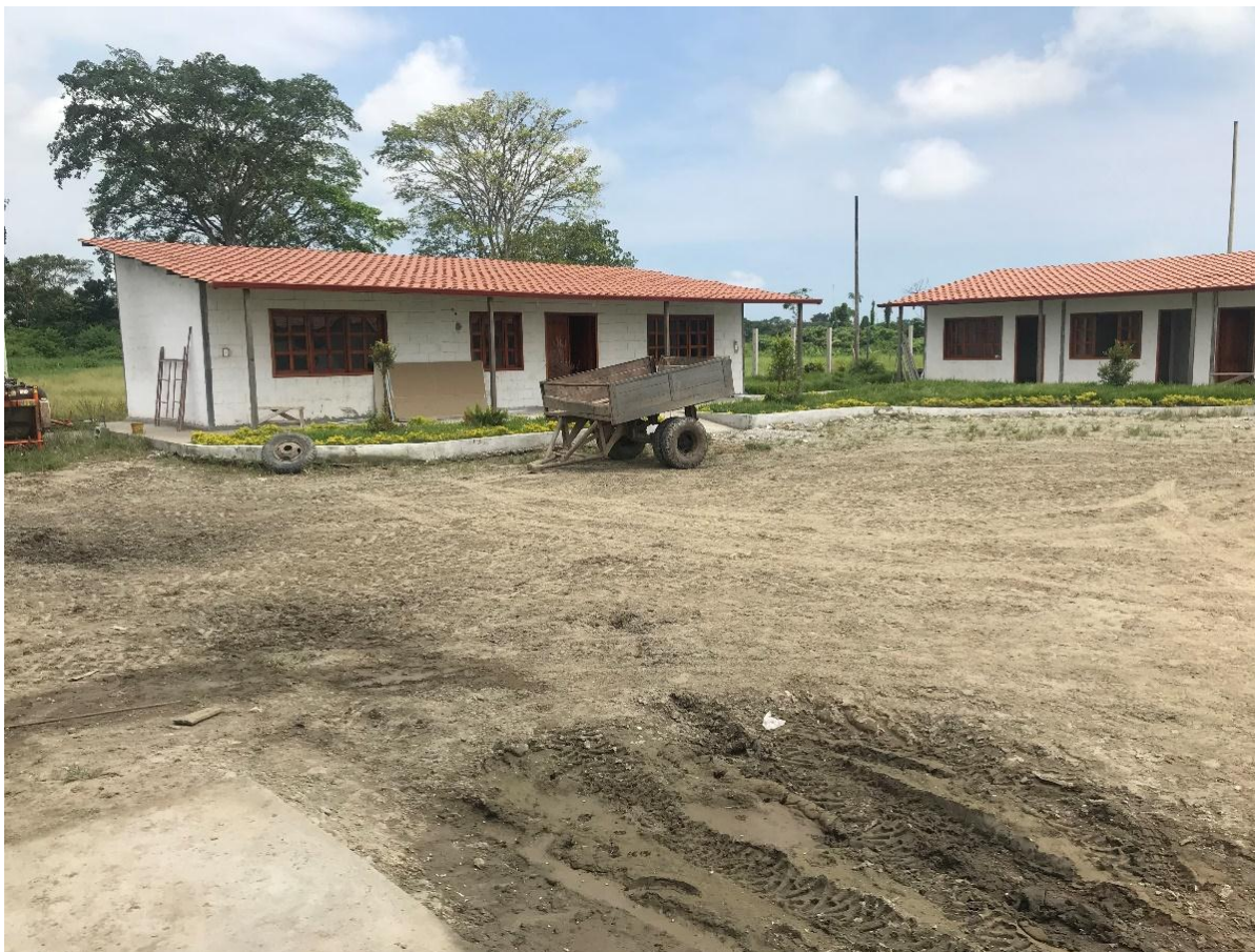
Fotografía 16. Finalizando la obra.
