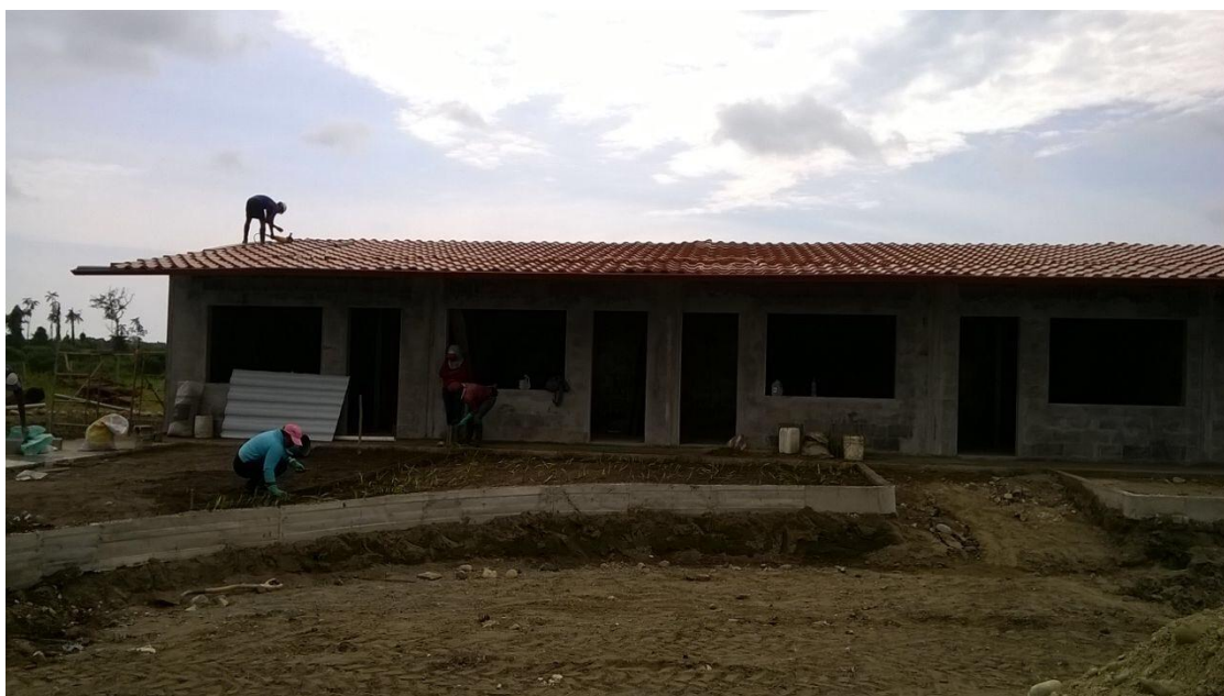
Fotografía 11. Techado de estructuras.
