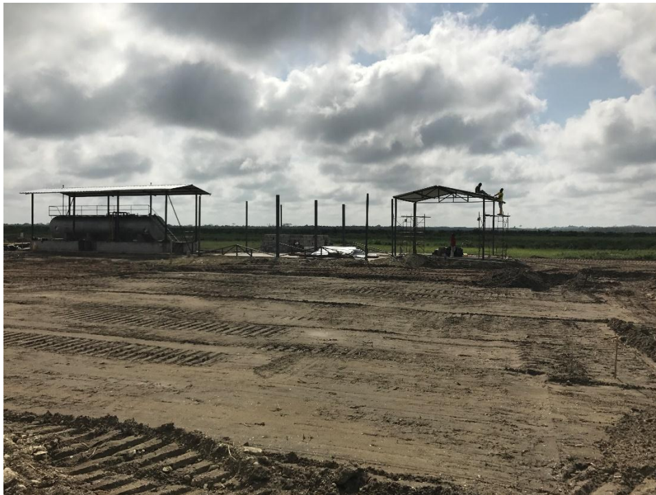
Fotografía 7. Armado de estructura metálica.
