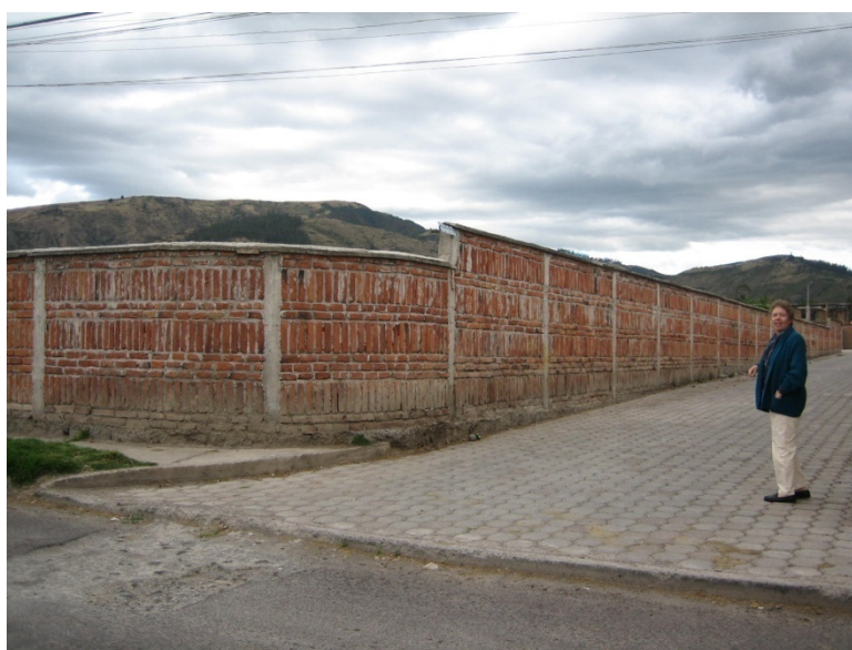
Fotografía 3-1. Vista exterior del lote
