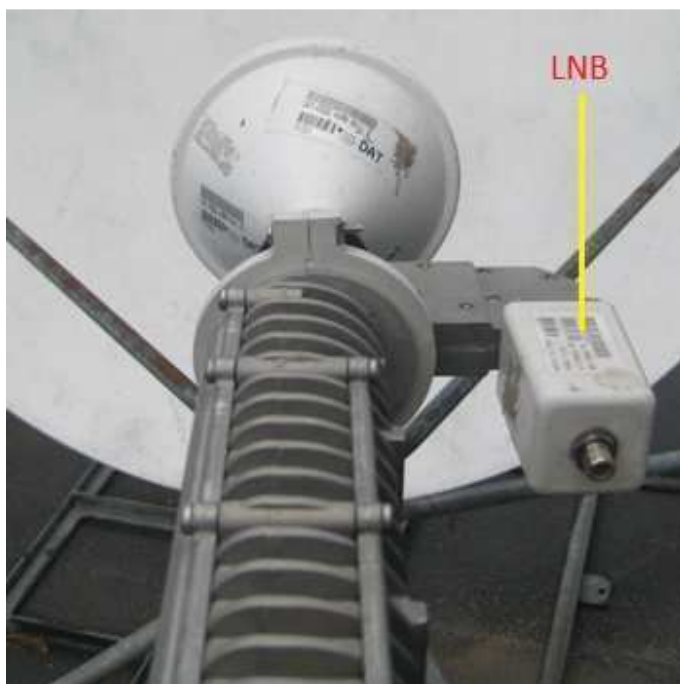
Figura 4.9. ODU y LNB. (Imagen real proporcionada por el ISP).
