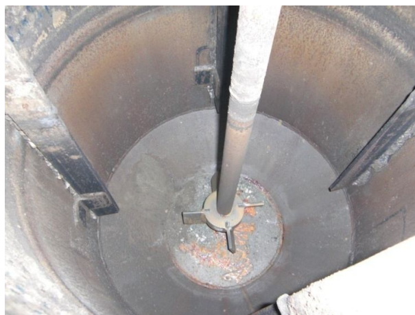
Figura 3.2 Fotografía del agitador y deflectores en el interior del reactor de lixiviación.
