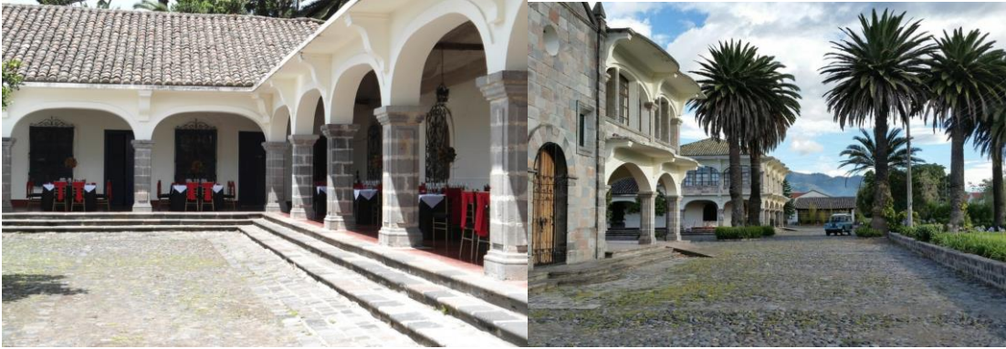
Figura 23 y 24: Respectivamente se observa materialidad envolvente
