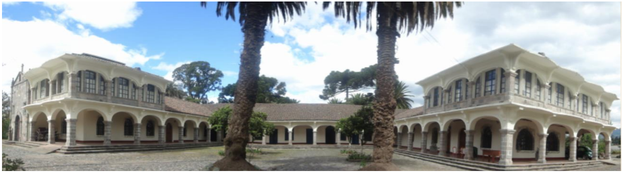
Figura 22: Fachada de la construcción de Hacienda San Isidro.
