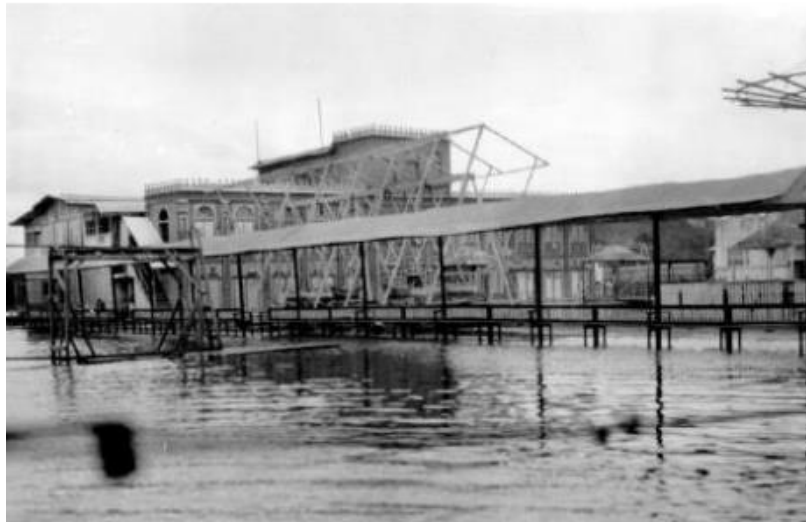
Figura 5: Instalaciones del American Park, 1928.
