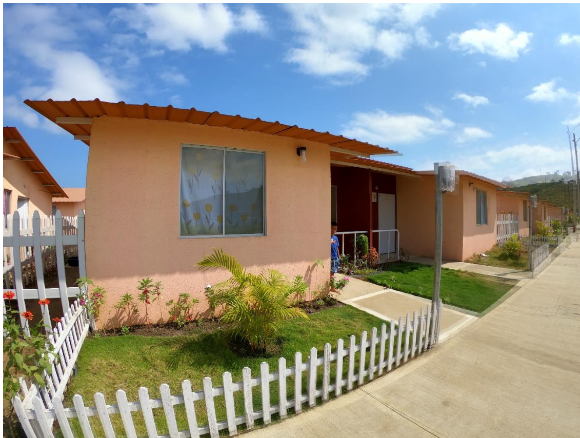
Fotografía 12 Fachada de Casas de Proyecto Fuente: Propio
