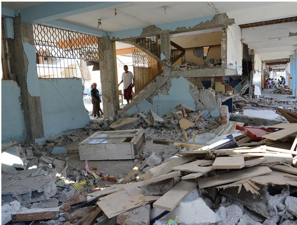
Fotografía 5 Daños en Escuelas Fuente: (Aguirre, 2016)
