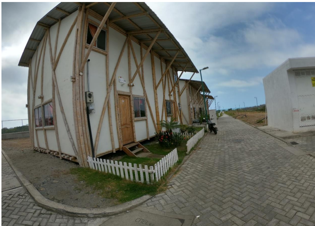
Fotografía 15 Vivienda en partes superior del Proyecto
