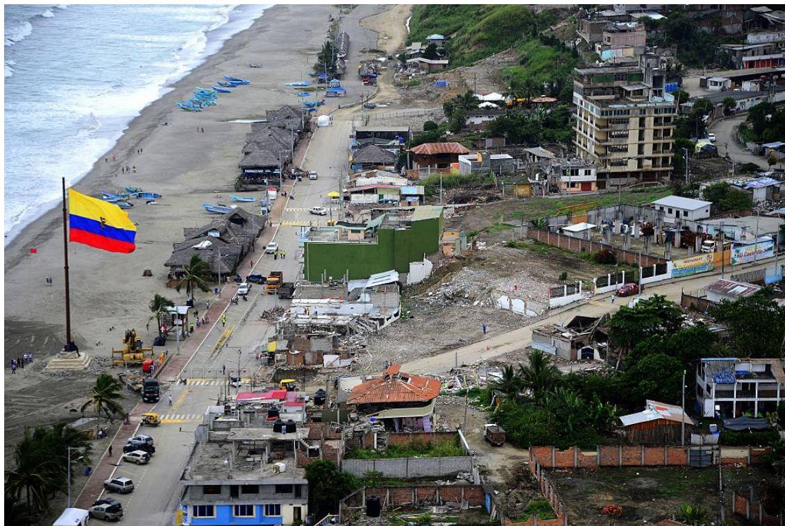
Fotografía 6 Daños en vivienda – Pedernales Fuente: (Aguirre, 2016)
