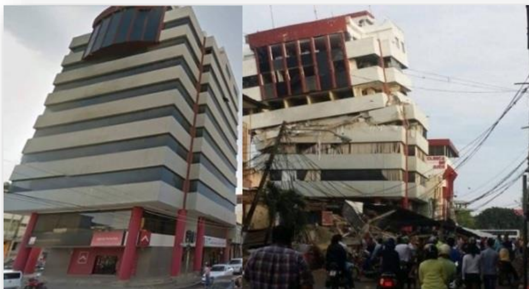
fotografía 9 Antes y después edificio Mutalista Pichincha (Alverca, 2016)
