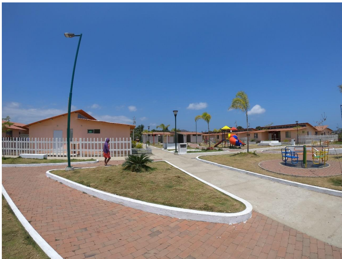
Fotografía 14 Áreas Sociales del proyecto Fuente: Propio
