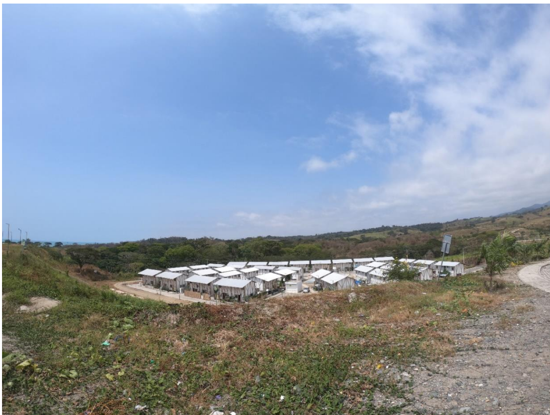
Fotografía 16 Zona Inferior del proyecto
