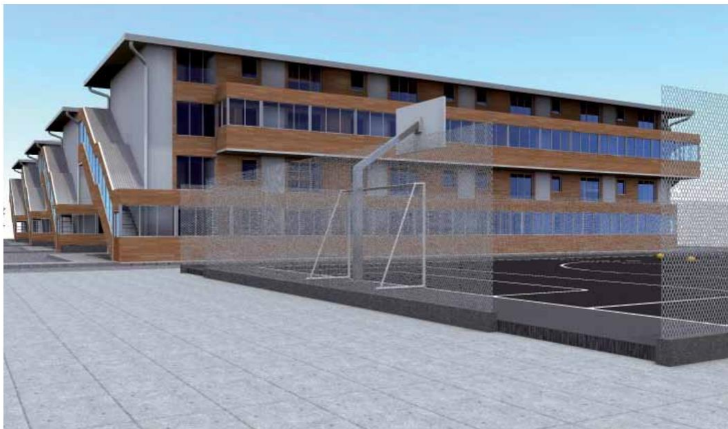
Ilustración 26 Proyecto después de Intervención Fuente: (Ministerio de Vivienda y Urbanismo, 2010)
