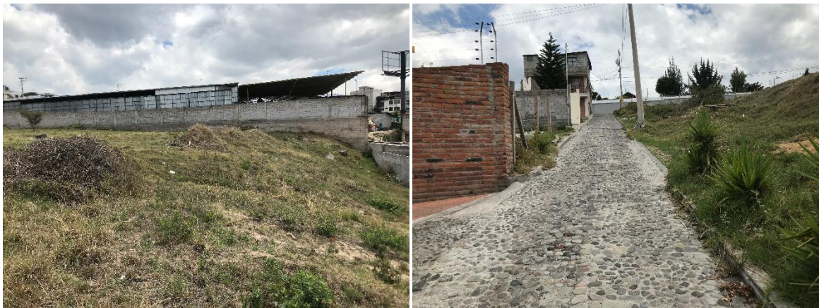
FOTOGRAFIA 1: Vista lado ESTE y OESTE Fuente: Daniela Avellán
