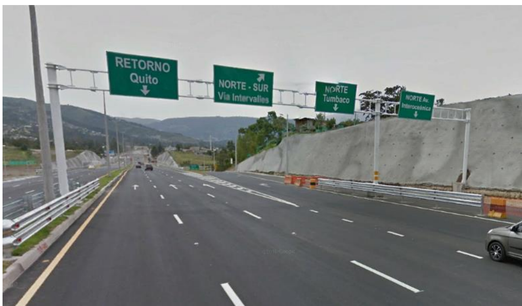
Figura 20. Señalización vertical, carteles informativos.
