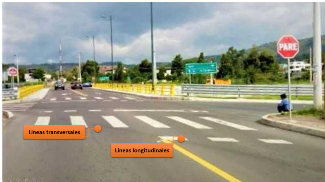
Figura 17. Señalización horizontal tramo 1.
