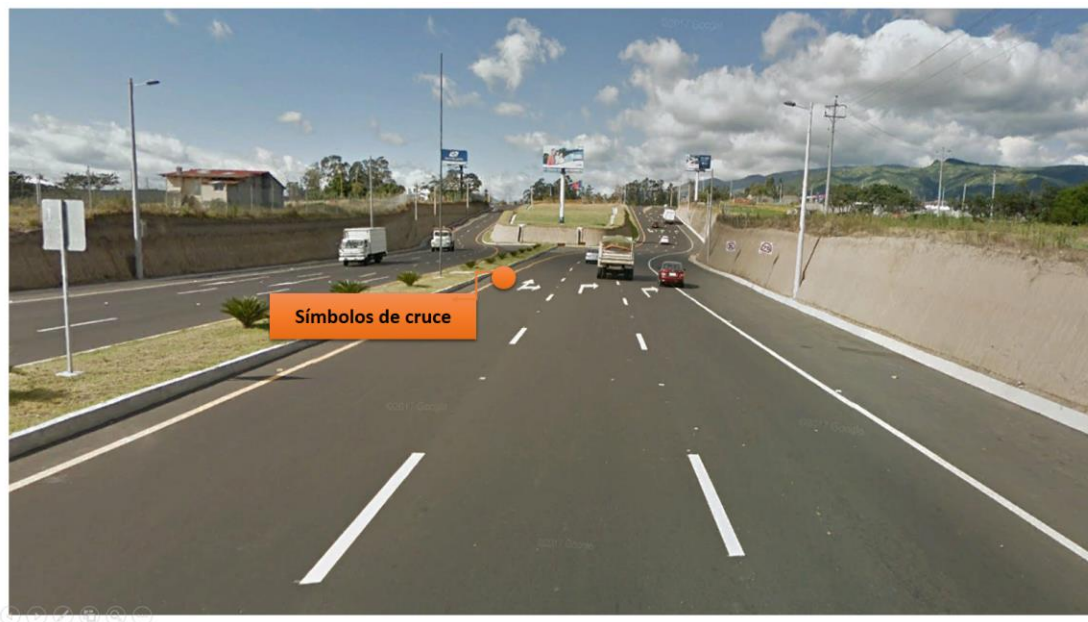
Figura 19. Señalización horizontal, símbolos.
