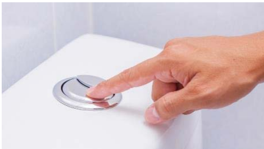
Imagen 7 Sistema doble descarga inodoro. Fuente: Internet
