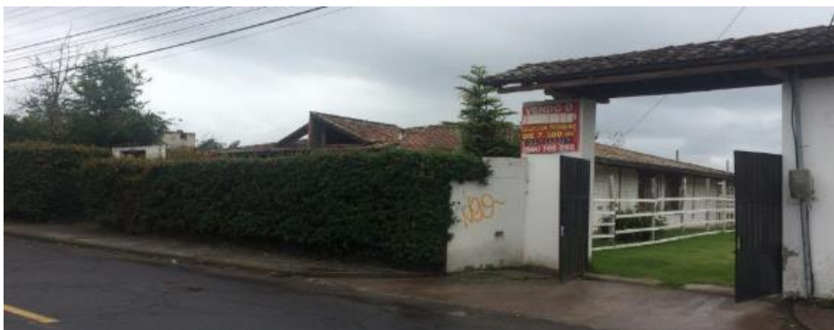
Fotografía 3.1 Ingreso al predio y vivienda existente. Fuente: Propia. Elaborado por: Pablo Estrada
