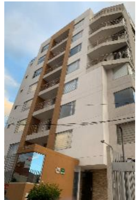
P4. Edificio Batan Plaza
