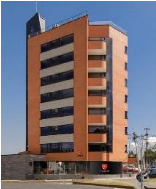
P1. Edificio Mouret
