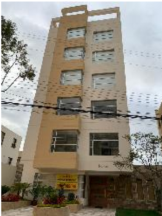
P3. Edificio Portet
