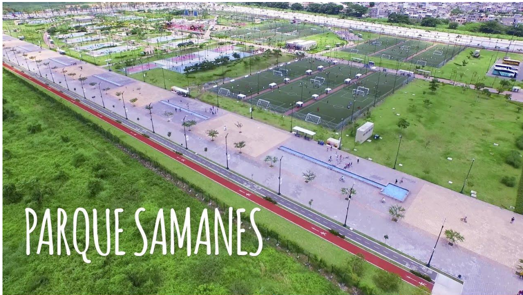
Figura 11: Vista general de las instalaciones del Parque Samanes – Vista Sur.
