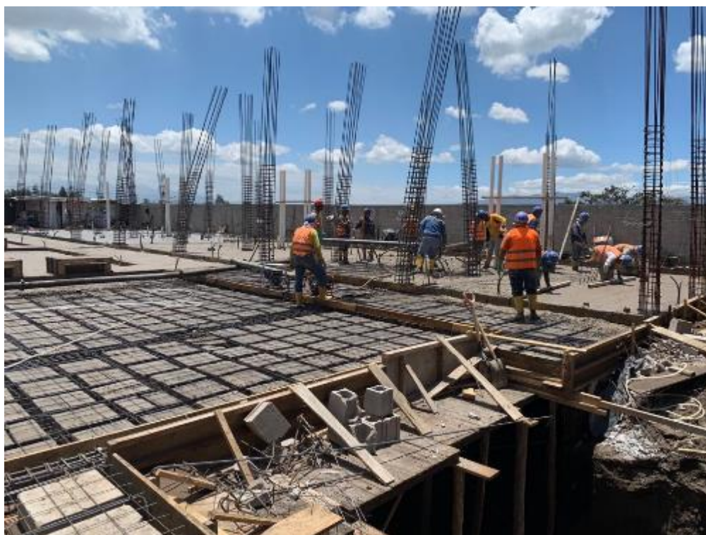
Gráfico 68: Fundición de losa de Parqueaderos, Abril 2019
