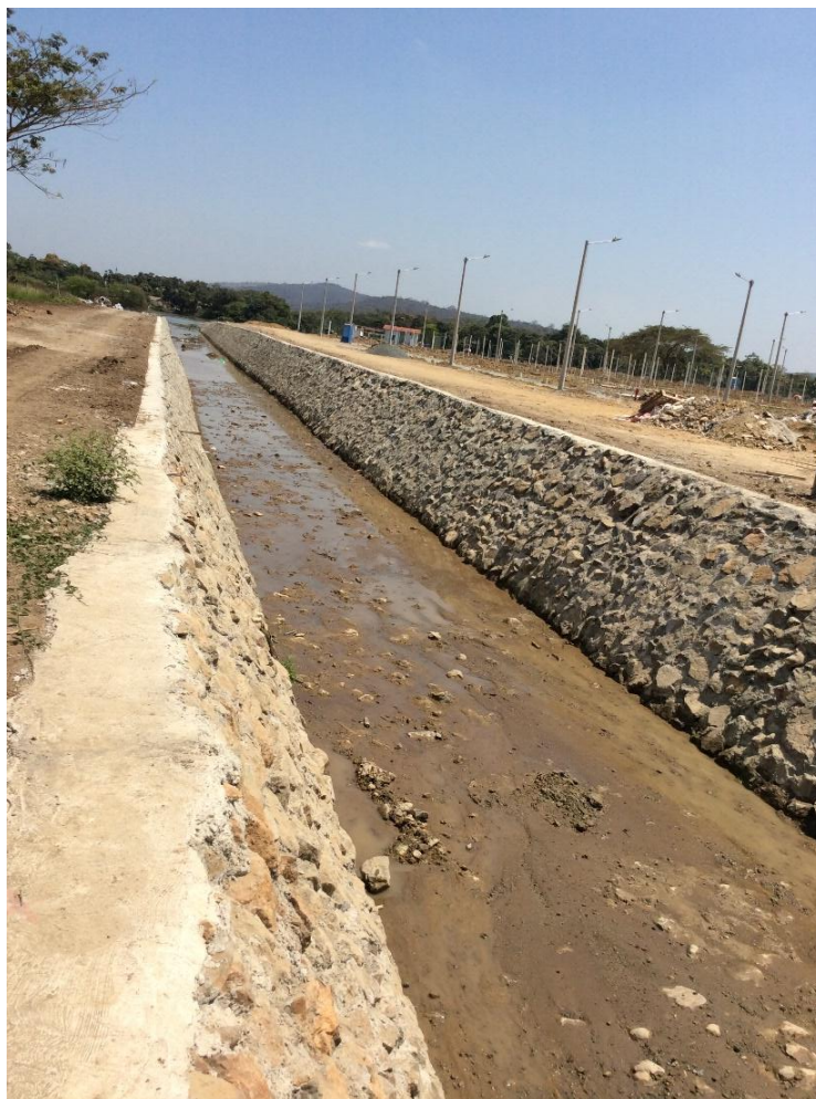
Figura 10.3. Canal de AA.LL.urbanización CS Etapa XI "Forestal" 16-septiembre-2019. Fuente. Propia.
