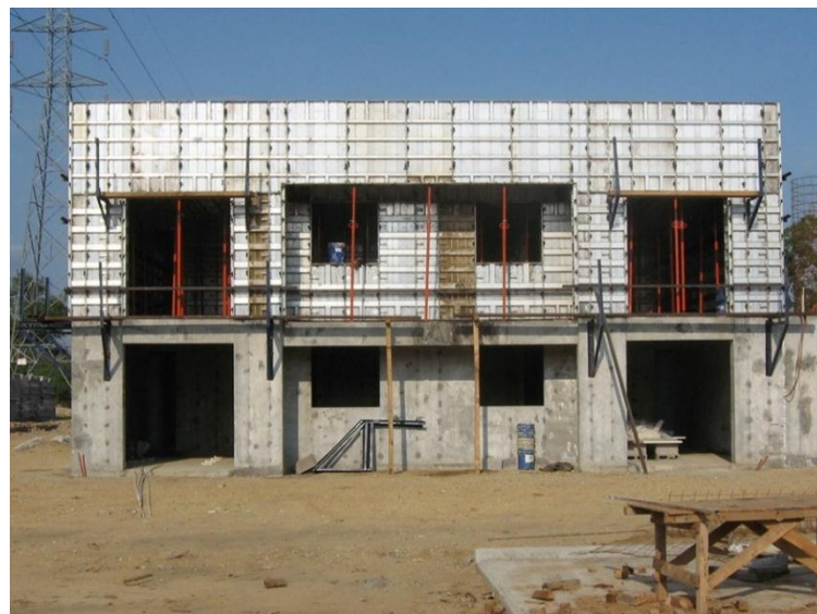
Figura 5.25. Encofrado exterior con formaletas de empresa Forsa ® para hormigonado de viviendas.
