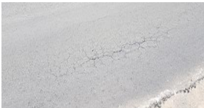
Figura 2 Deformación de la carpeta – piel de cocodrilo
