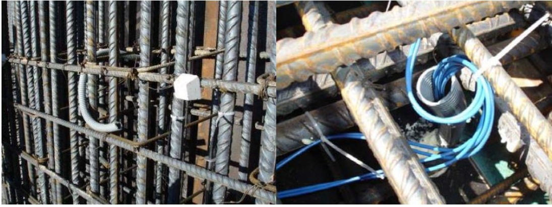
Figura 31: Protección del cable.
