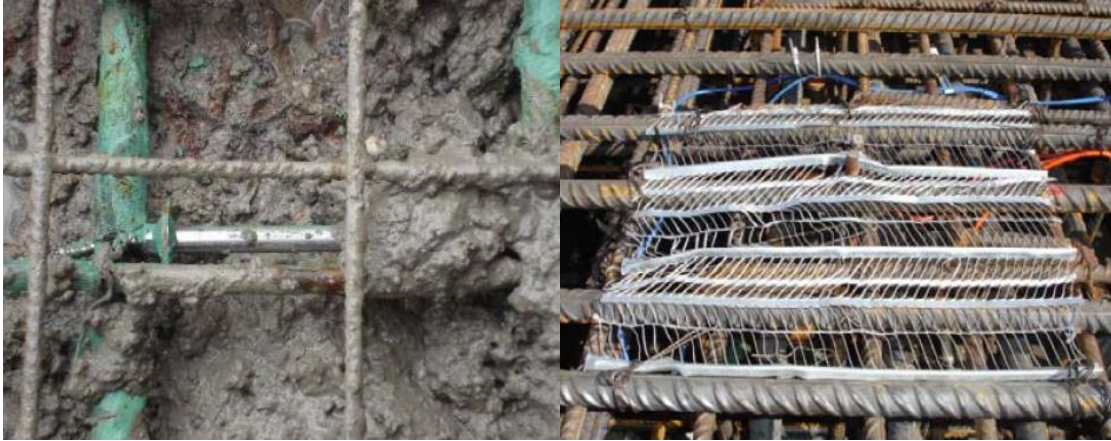
Figura 36: Hormigonado y red de protección.
