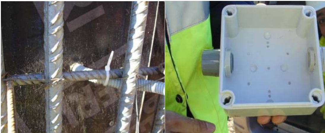
Figura 32: Salida directa de tubo, caja de protección.
