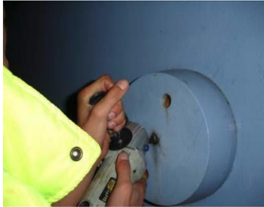
Figura 25: Preparación del área de trabajo
