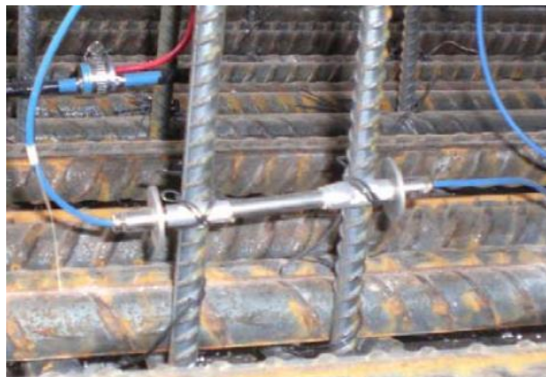
Figura 34: Fijado del sensor.
