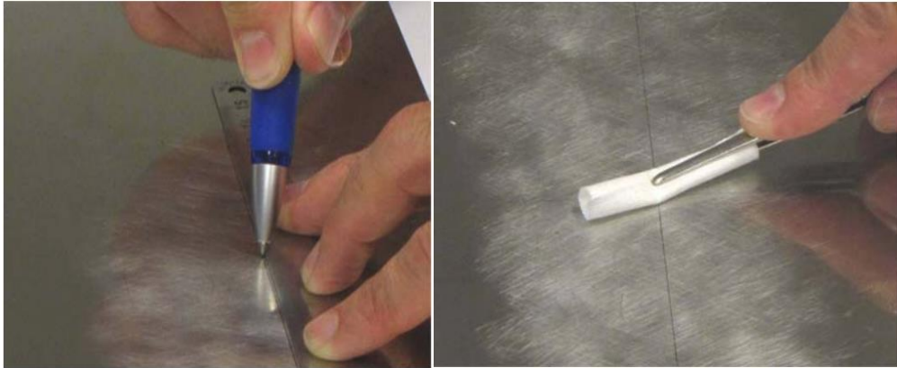
Figura 27: Marcado de líneas horizontales y verticales y limpieza del área
