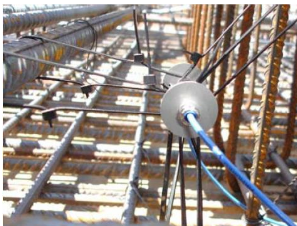
Figura 35: Fijado del sensor.
