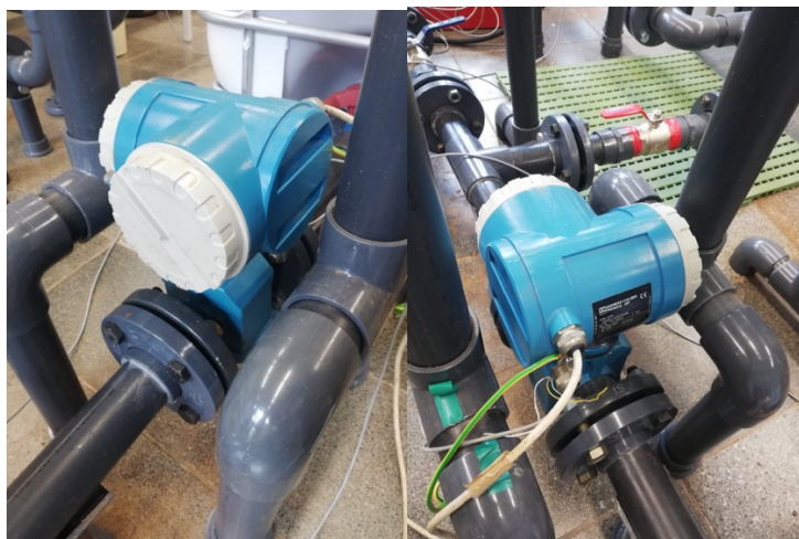
Figura 8. Caudalímetro electromagnético.
