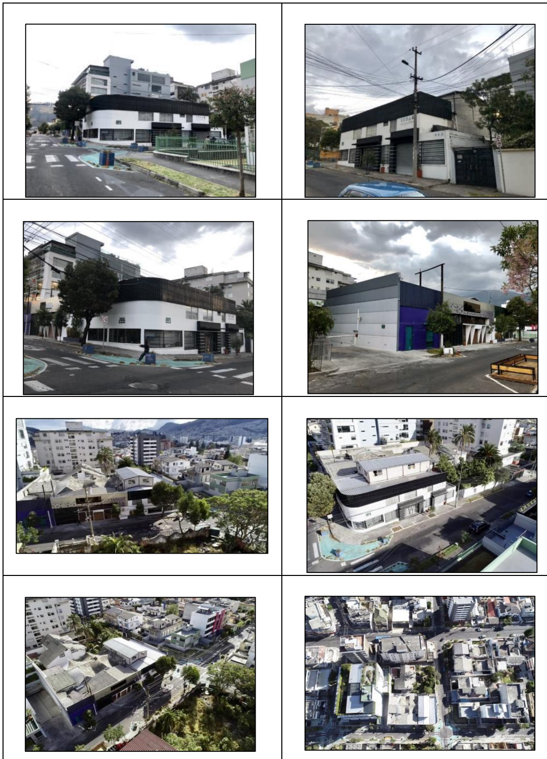
Figuras 9-16: Imágenes actuales de las instalaciones donde funcionará el nuevo instituto
