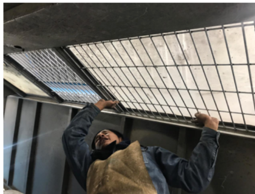
Figura N.38.: Protecciones de puertas.
