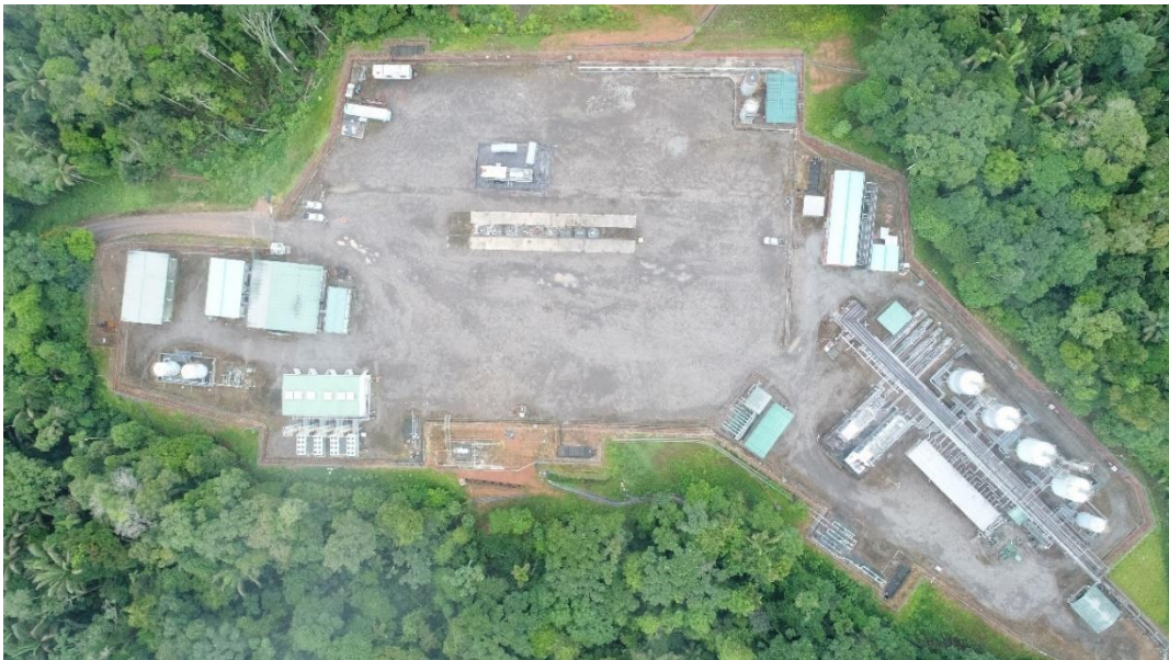
Figura 8. Estación de separación (ANDES, 2019)
