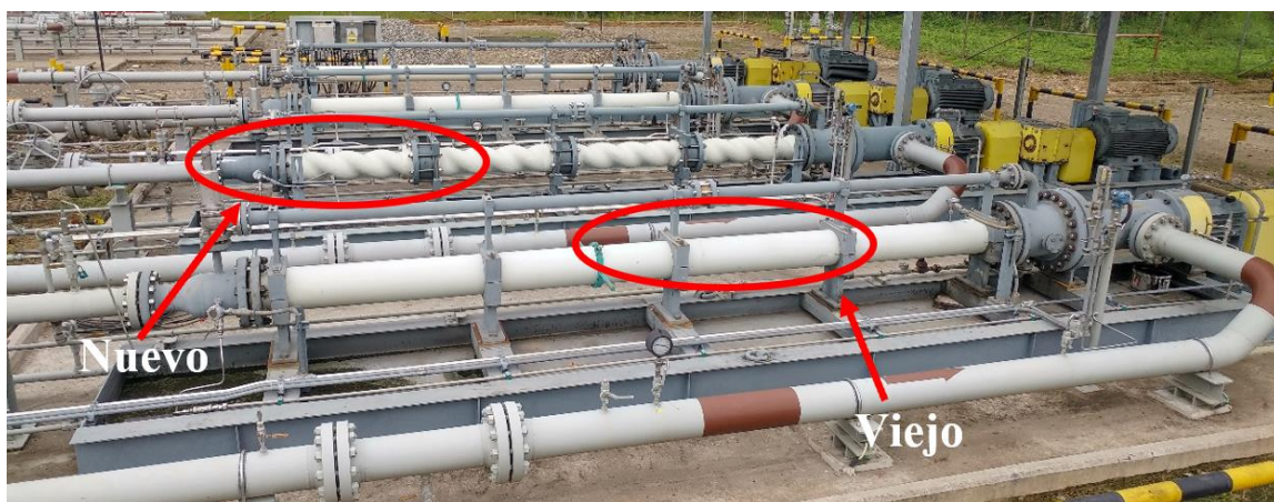
Figura 28. Bombas MPP con Estatores Viejos y Nuevos
