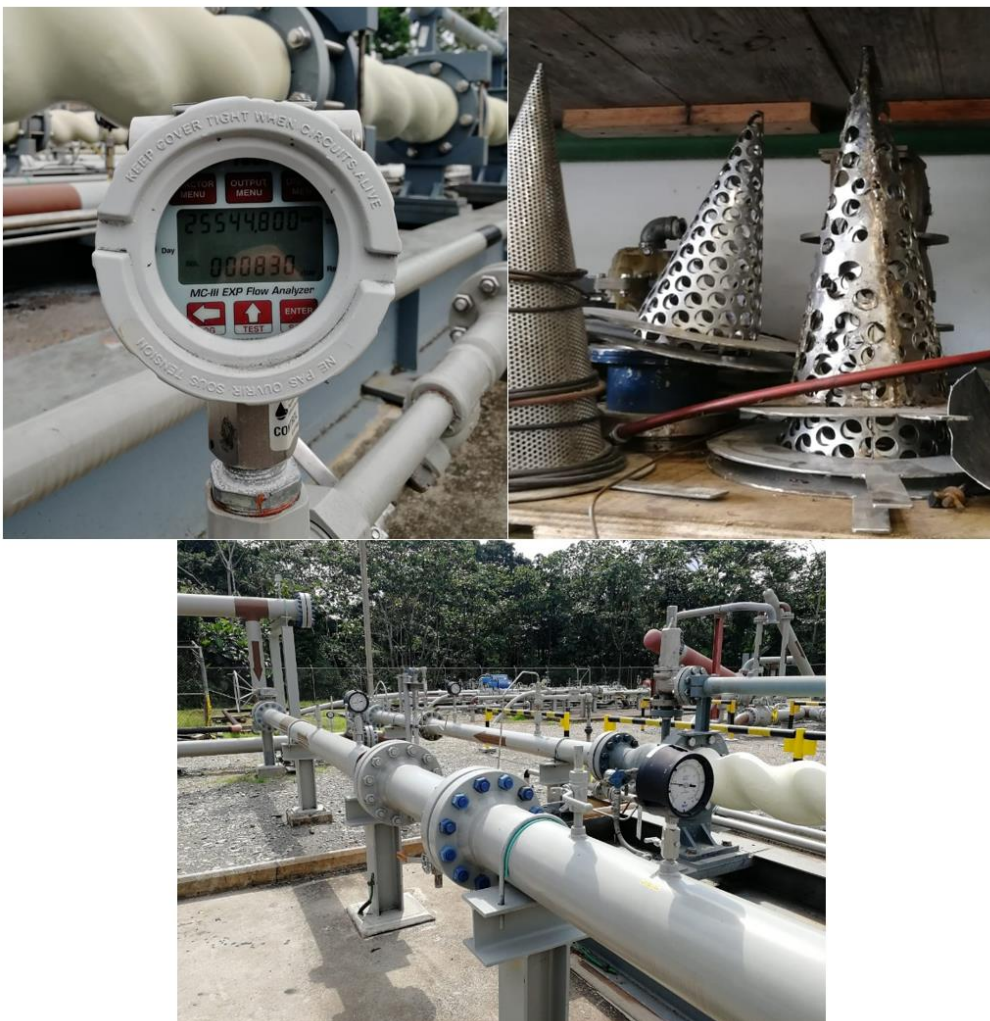
Figura 18. Sistemas de protección de la MPP
