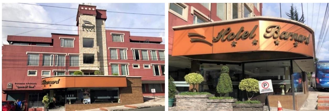
Figura 9: Imágenes de la fachada frontal y posterior del Hotel Barnard (2019).
