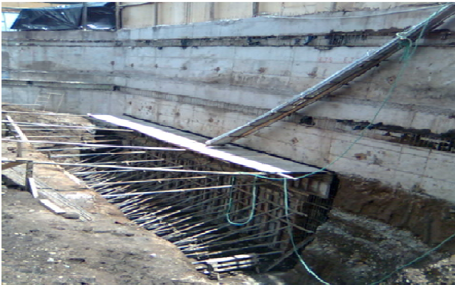
Imagen 33: Anclaje de Muros
