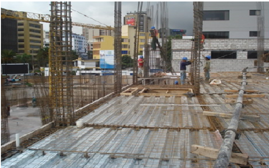
Imagen 34: Sistema Viga Columna
