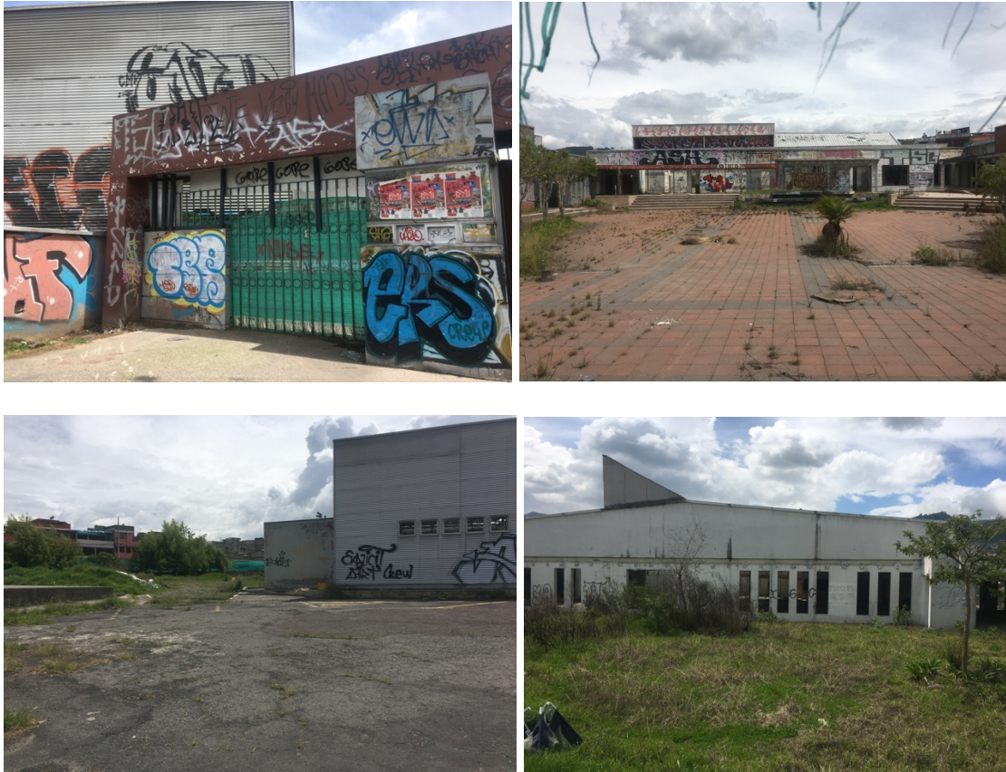
Figura # 10. Estado actual ex Registro Civil Turubamba, Foto Original (2019).
