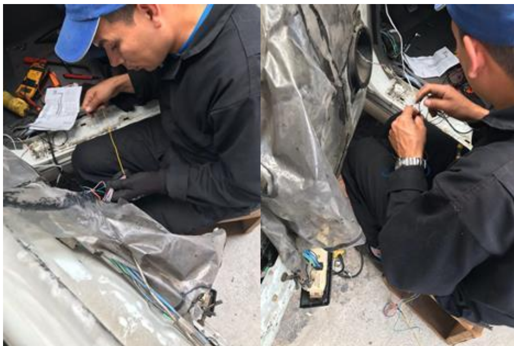
Imagen 40. Instalación del botón o pulsador (Autor).
