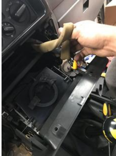
Imagen 26. Instalación del sensor magnético para el encendido con botón (Autor).
