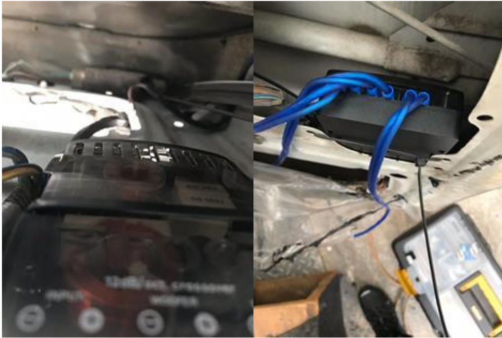
Imagen 49. Ubicación del crossover en la puerta y como fue asegurado (Autor).
