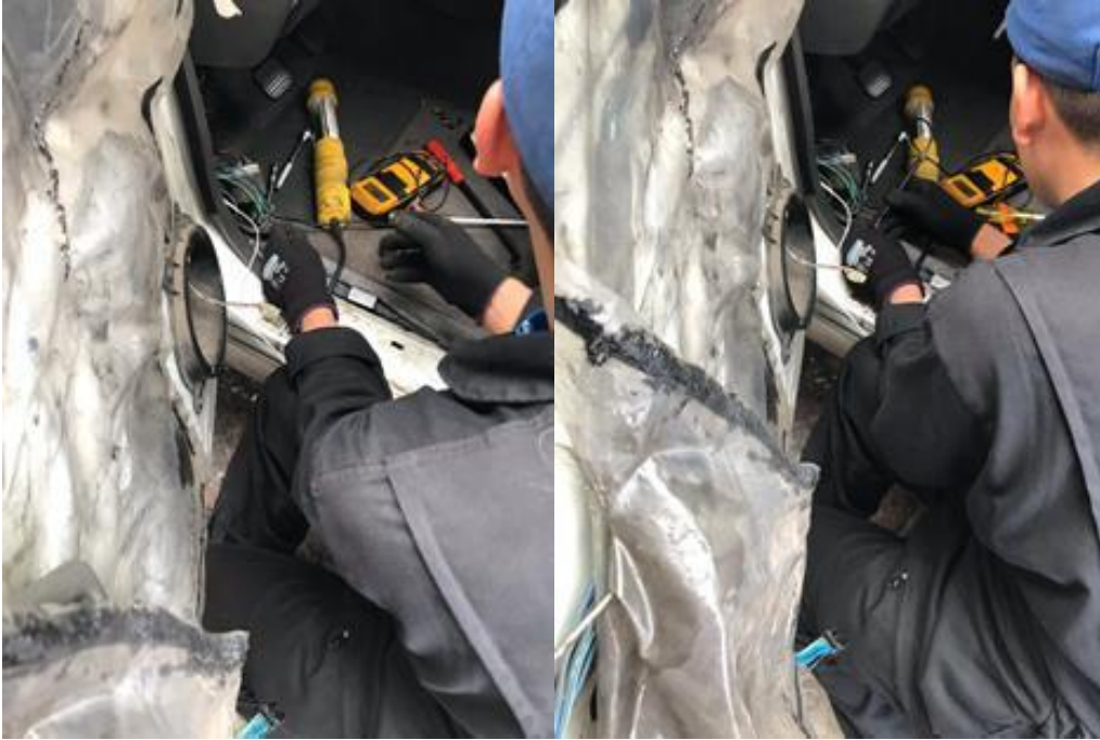
Imagen 38. Comprobación de cables para la instalación de los parlantes (Autor).
