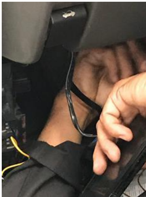
Imagen 34. Instalación del módulo de la alarma. Está escondido debajo del volante detrás de la tapicería. (Autor).
