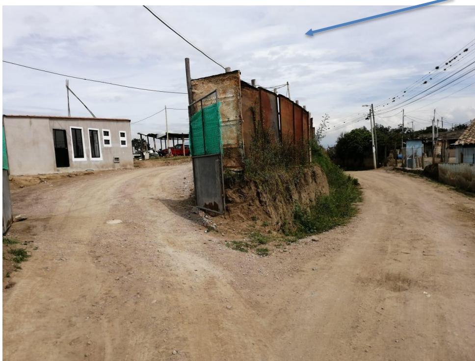
Ilustración 5.5 Entrada que no sufre afectación Recuperado el 29 de mayo del 2019 Fuente: Trabajo de campo Francisco Núñez
