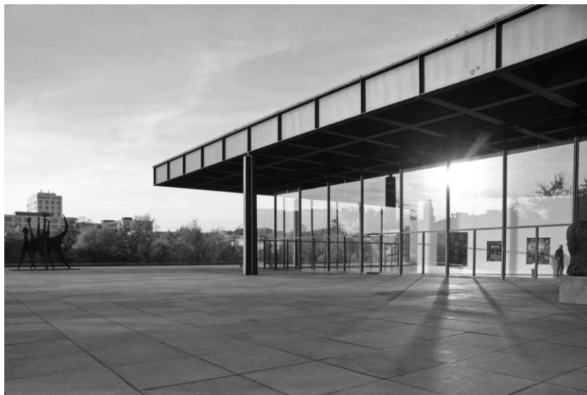
Ilustración 3: Vista externa Galería Nacional de Mies van der Rohe. https://www.plataformaarquitectura.cl/cl/762572/clasicos-de-arquitectura-neue-nationalgalerie-mies-van-der-rohe
