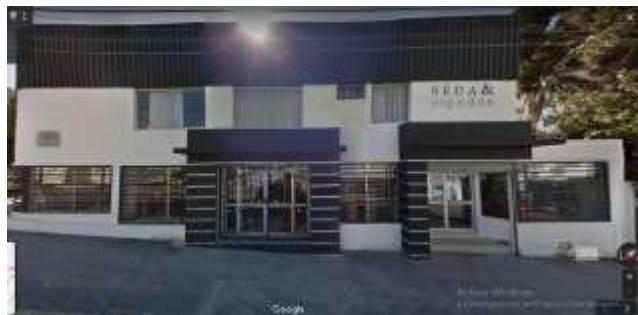
Figura 9. Fotografía fachada Lugo, Seda y Algodón. Google Maps
