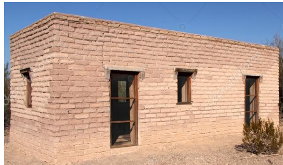
Ilustración 4: Mampostería no reforzada Fuente: IngeCivil, 2020
