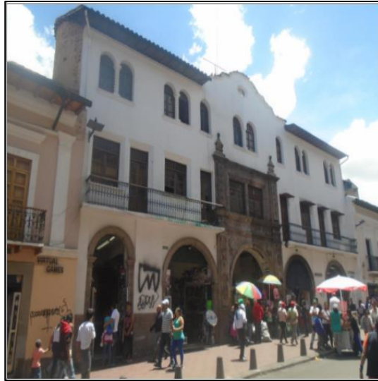
Ilustración 15: Edificación característica de MUR_SAmerica_LWAL-DNO_H3 Elaborado por Jadira Llugsha
