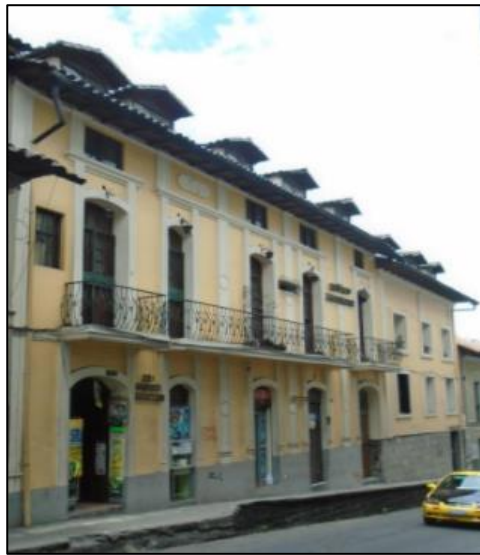
Ilustración 14: Edificación característica de MUR-ADO_SAmerica_LWAL-DNO_H2 Elaborado por Jadira Llugsha
